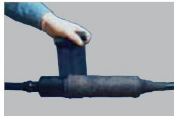
6. Для повышения жесткости муфты весь корпус муфты обматывается лентой Armorcast™
