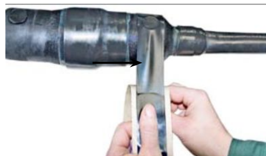
Наложение ленты VM поверх пробок
