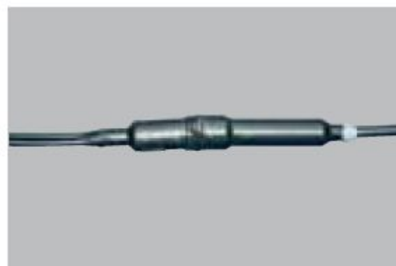
5. На сросток надвигаются полумуфты, стыки обматываются мастикой и виниловой лентой
