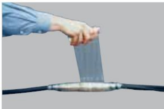
4. Компаунд сдавливается путем обмотки сростка эластичной виниловой лентой
