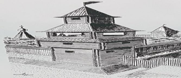
Расчатная Башня Белгородского кремля 1644 г. Реконструкция А.И. Ильина
