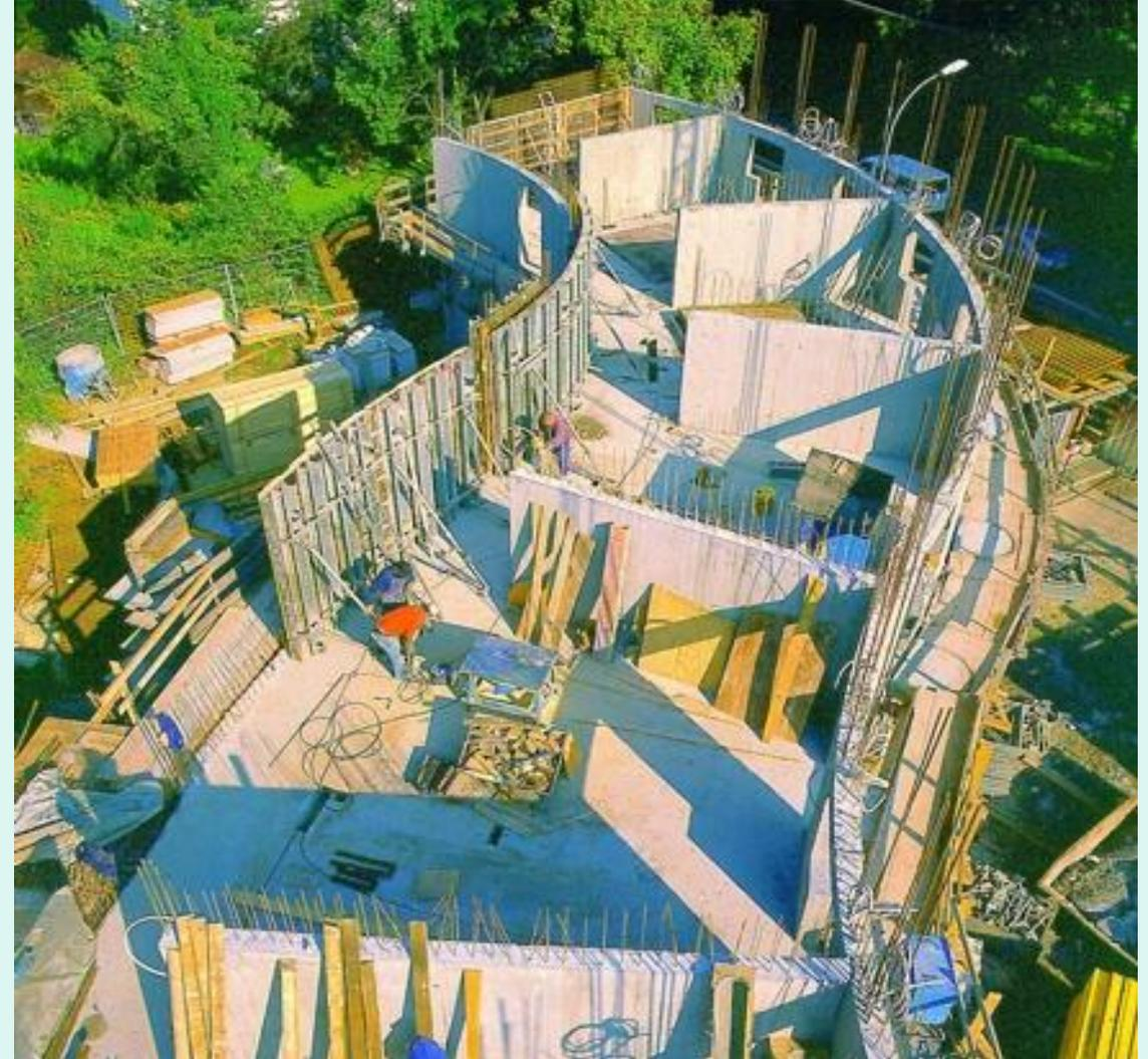
Наружные несущие стены бескаркасного здания из железобетона
