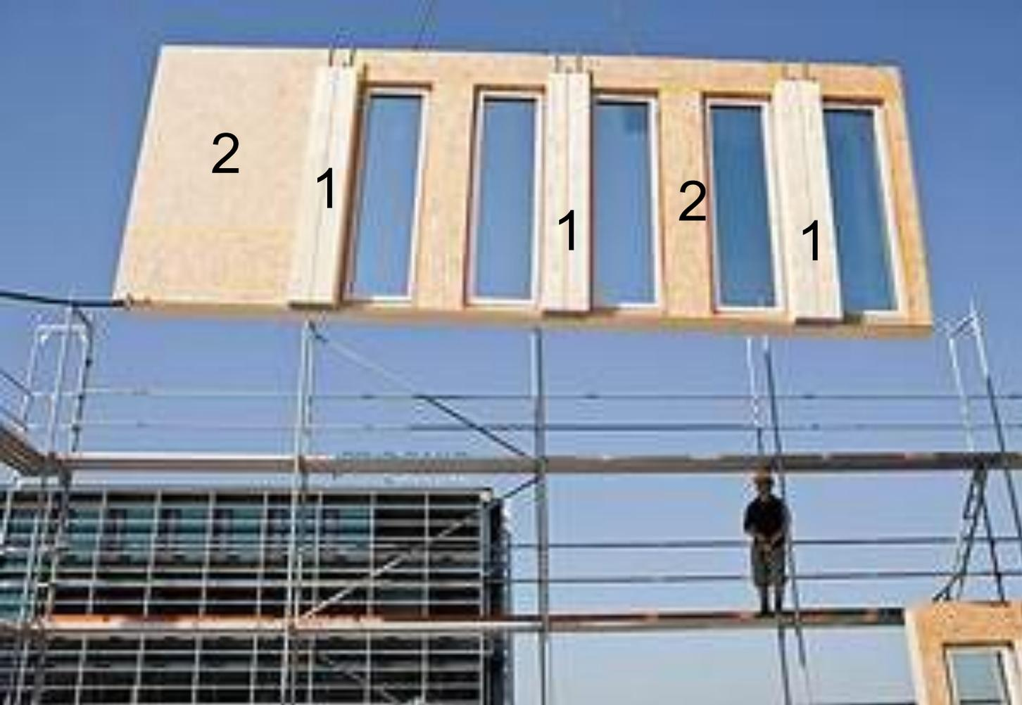
Несущая панель для наружных и внутренних стен бескаркасного здания для наружных и внутренних стен бескаркасного здания:
