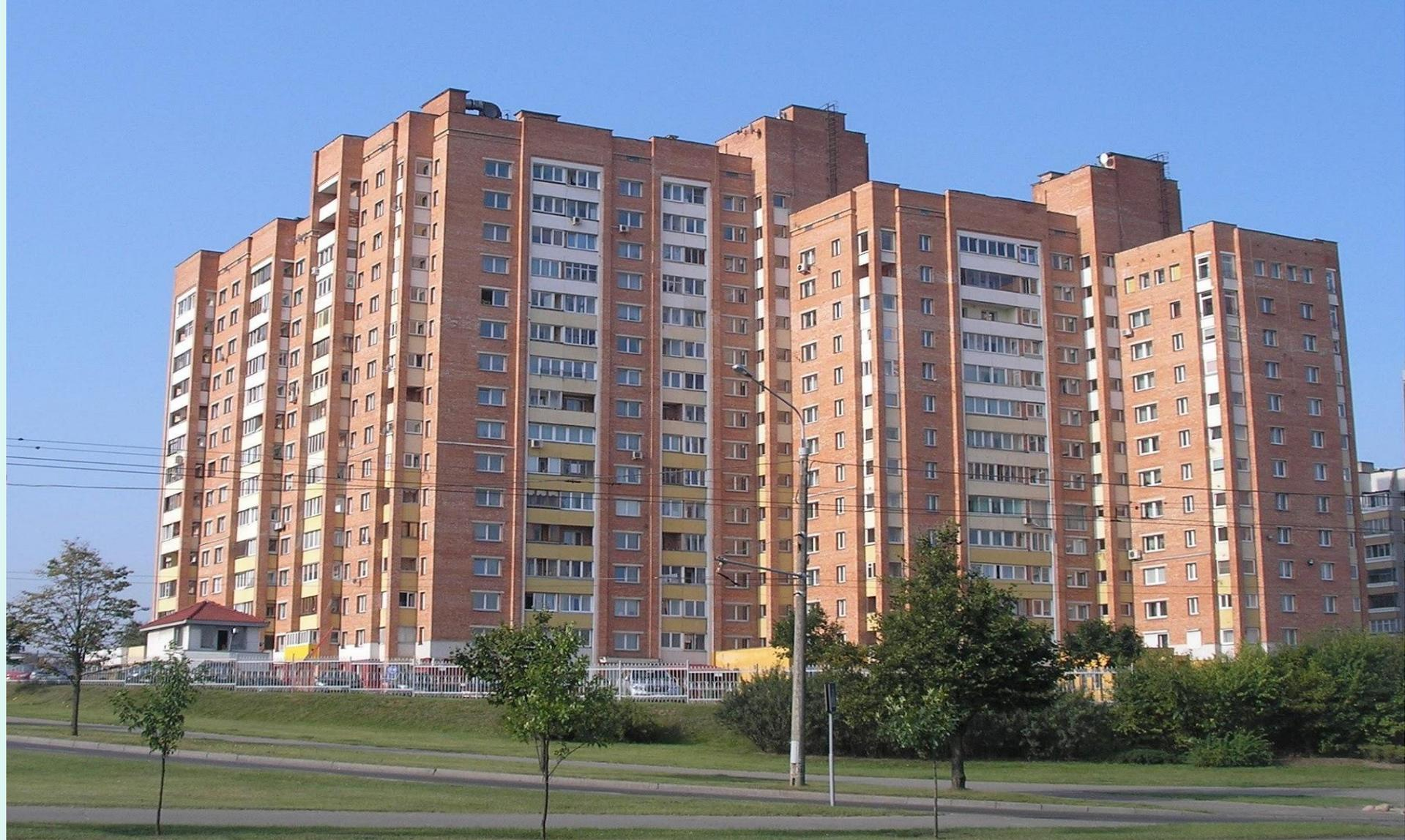
Наружные несущие стены бескаркасного здания из керамических кирпичей
