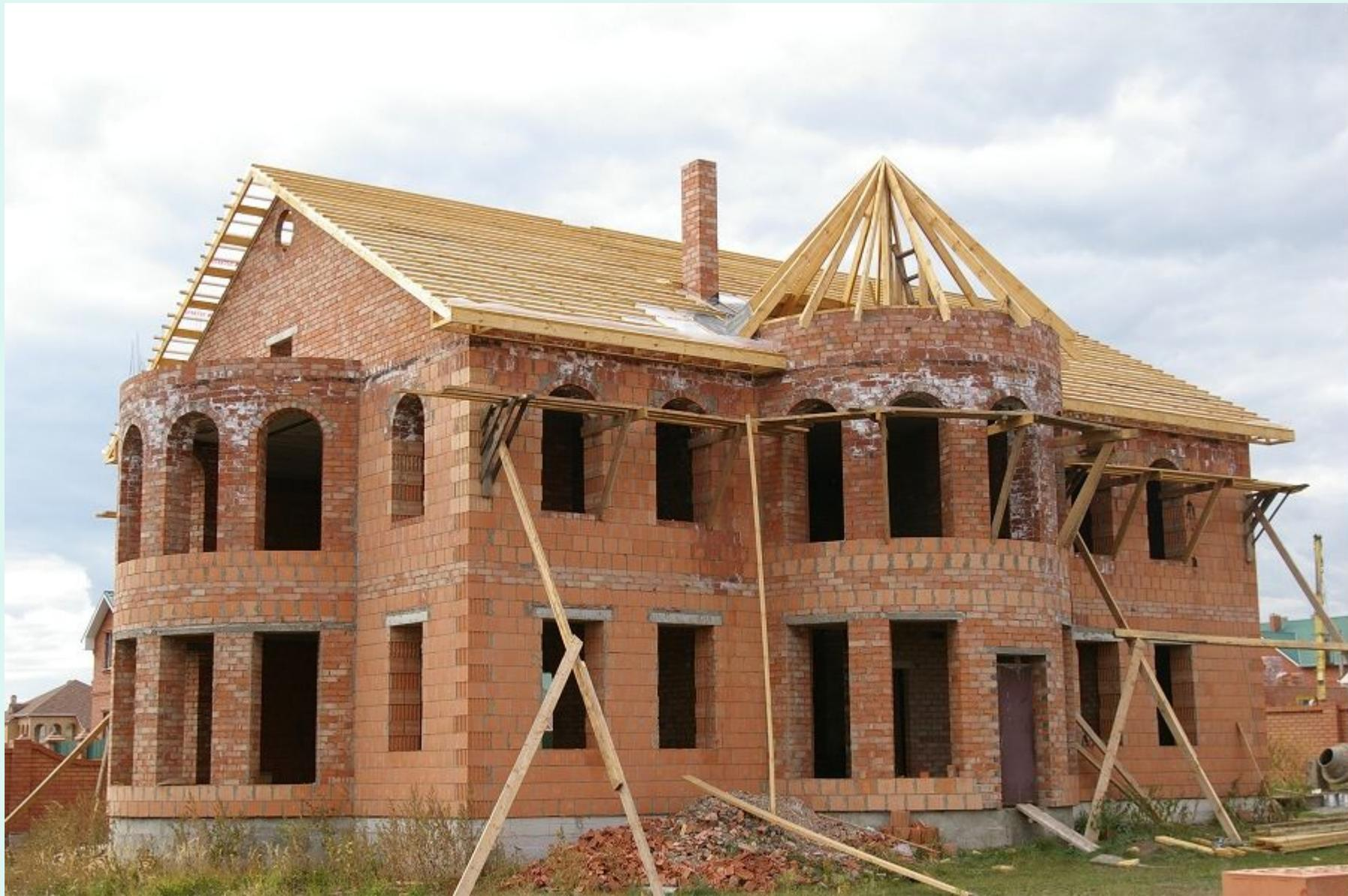
Наружные несущие стены бескаркасного здания из керамических блоков
