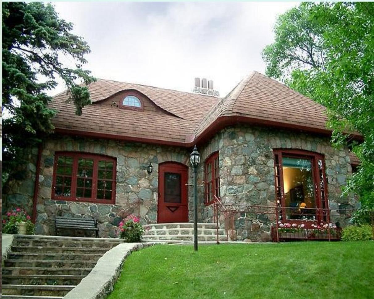
Наружные несущие стены бескаркасного здания из природного камня
