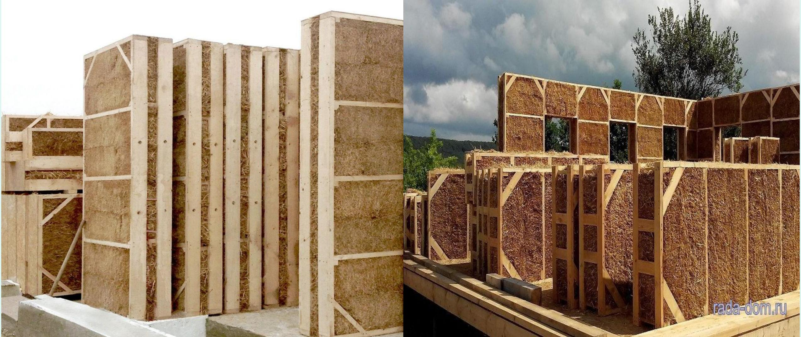
Каркасные древесно стружечные панели для наружных и внутренних стен бескаркасного здания
