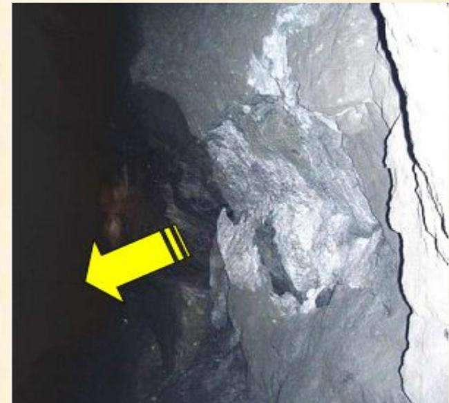
**Интенсивное заколообразование** – возникновение заколов вслед за их оборкой. Происходит по ненарушенному массиву и не связано с трещиноватостью, слоистостью и сланцеватостью. Сопровождается треском. Образующиеся и отделяющиеся при этом плиты повторяют по форме контур выработки;
