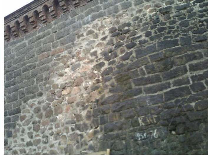
Рис.4. Термограмма и фотография неотапливаемого здания цейхгауза в зимний период. Предположительно, заложенный дверной проем.
