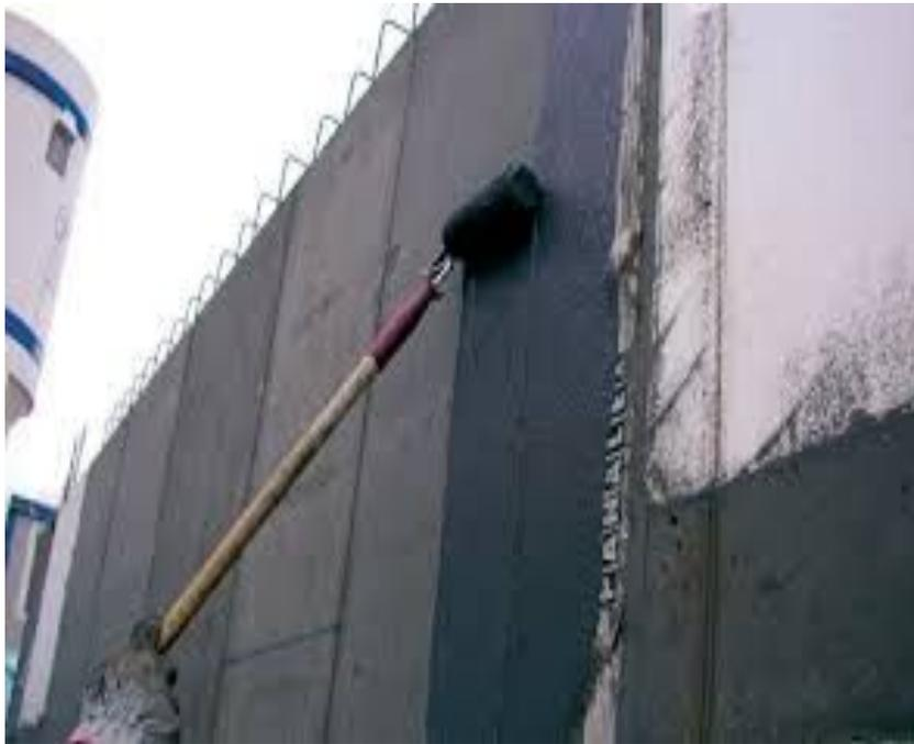
Для того, чтобы жилой дом эксплуатировался как можно дольше необходимо правильно защитить стены его фундамента от разрушительного воздействия грунтовых, дождевых и талых вод. Гидроизоляция стен предотвращает пропитывание бетона или кирпича влагой, что значительно снижает уровень их промерзания в зимний период и делает дом теплее.
