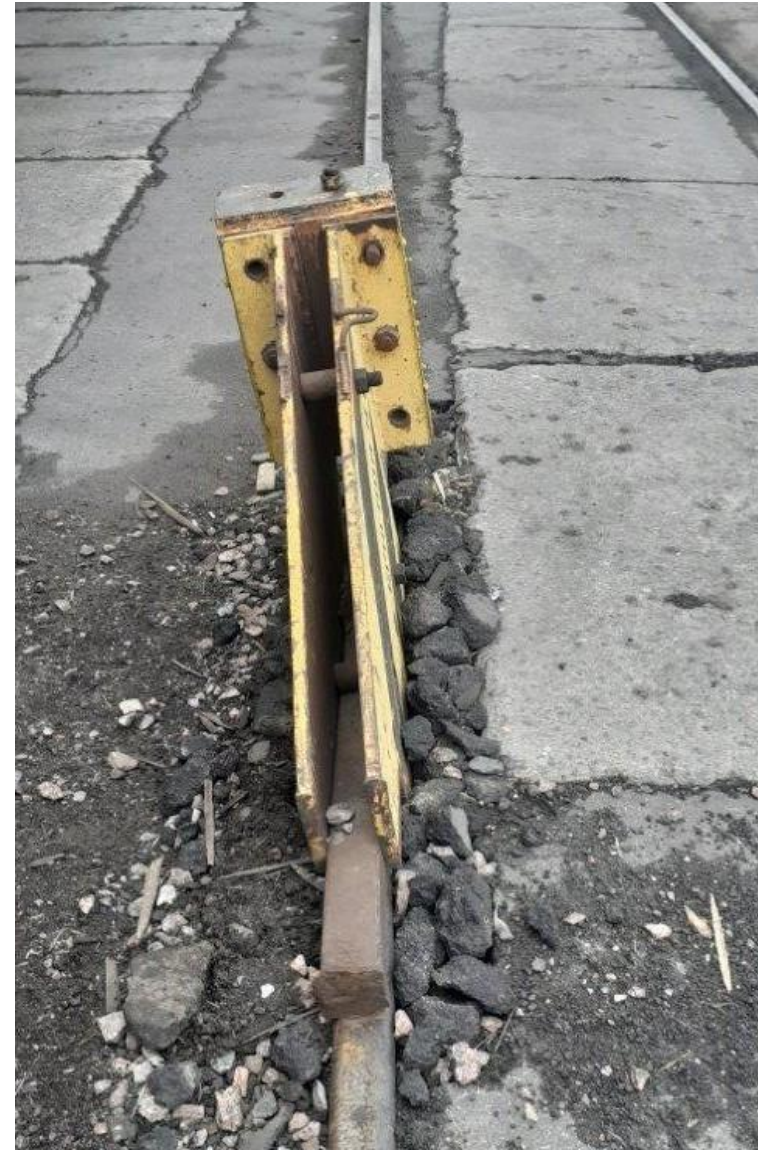
Не закрепленный подкрановый тупик.
