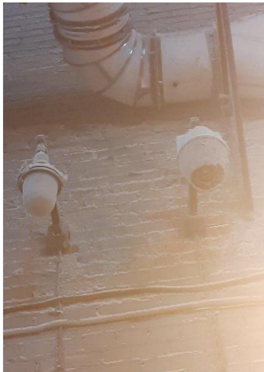
Отсутствие ламп, плафонов.
