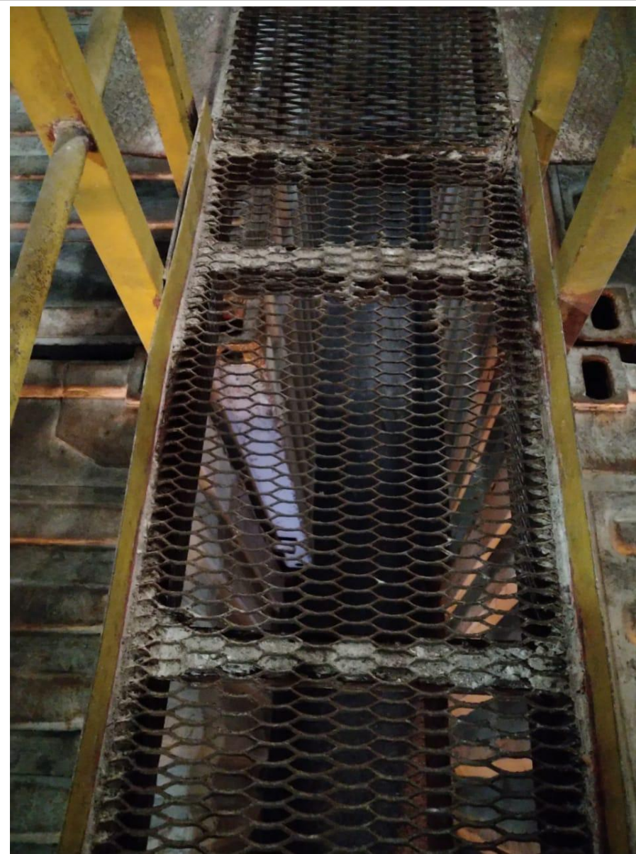
Деформированная решетка настила на проходе.
