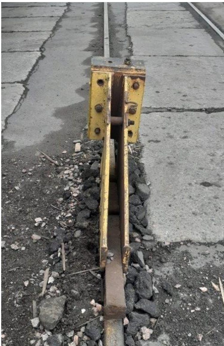
Не закрепленный подкрановый тупик.
