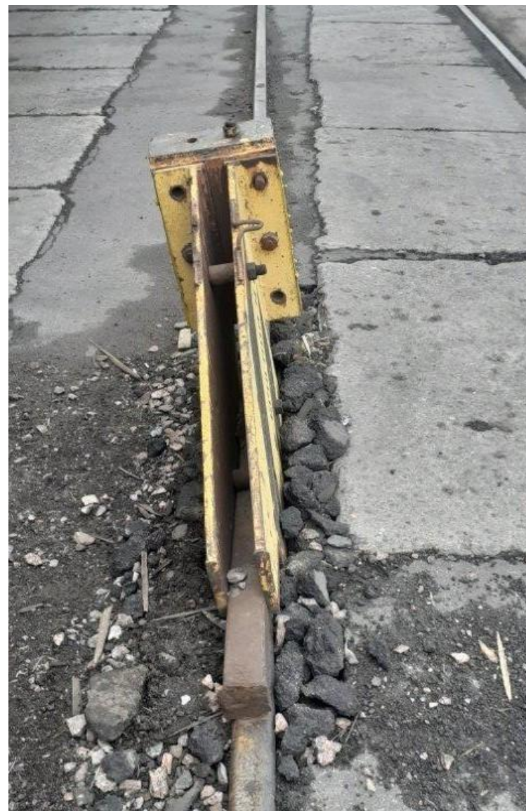
Не закрепленный подкрановый тупик.
