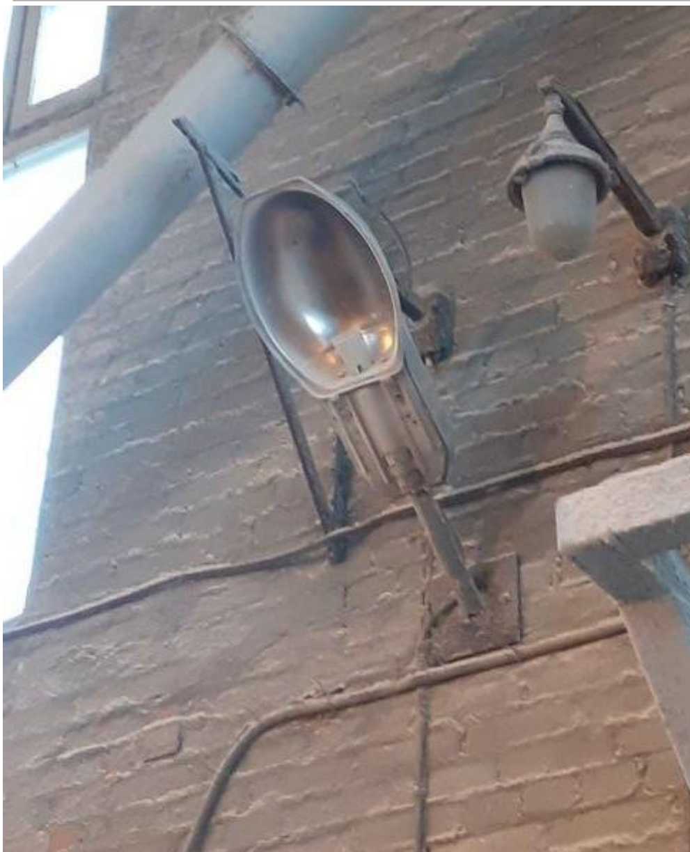
Отсутствие ламп, плафонов.
