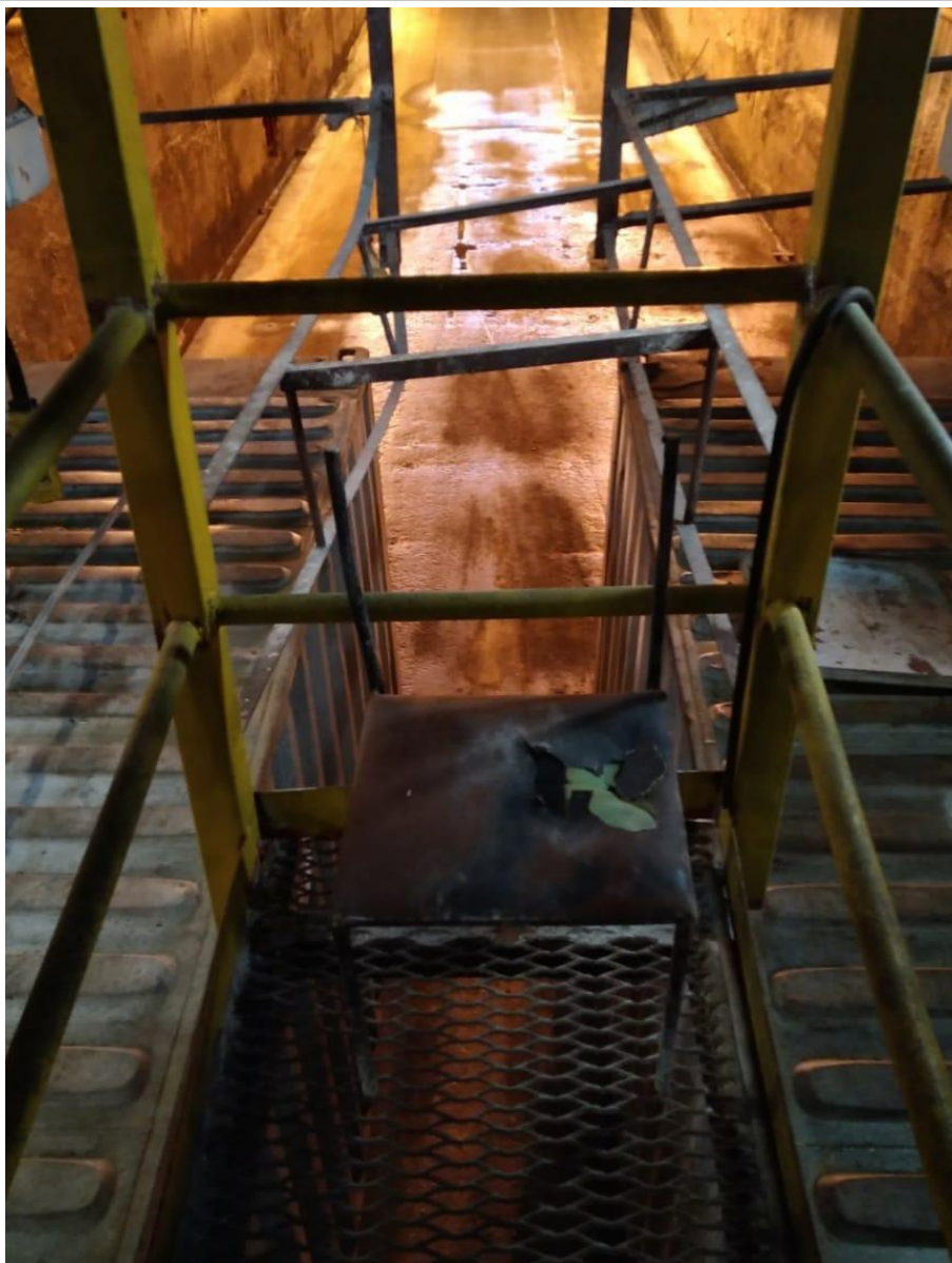
Деформированная решетка настила на проходе.
