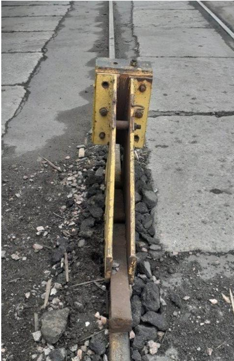
Не закрепленный подкрановый тупик.
