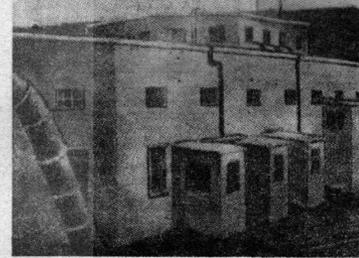
Этот снимок был помещен в первом номере «Советской Печенги» 7 ноября 1946 года. На нем — восстановленная силовая станция комбината «Печеникиль». Она должна была обеспечивать рудник и конверторы плавильного цеха сжатым воздухом. Ее восстановление вел рабочий «Промстроя» и комбината.
