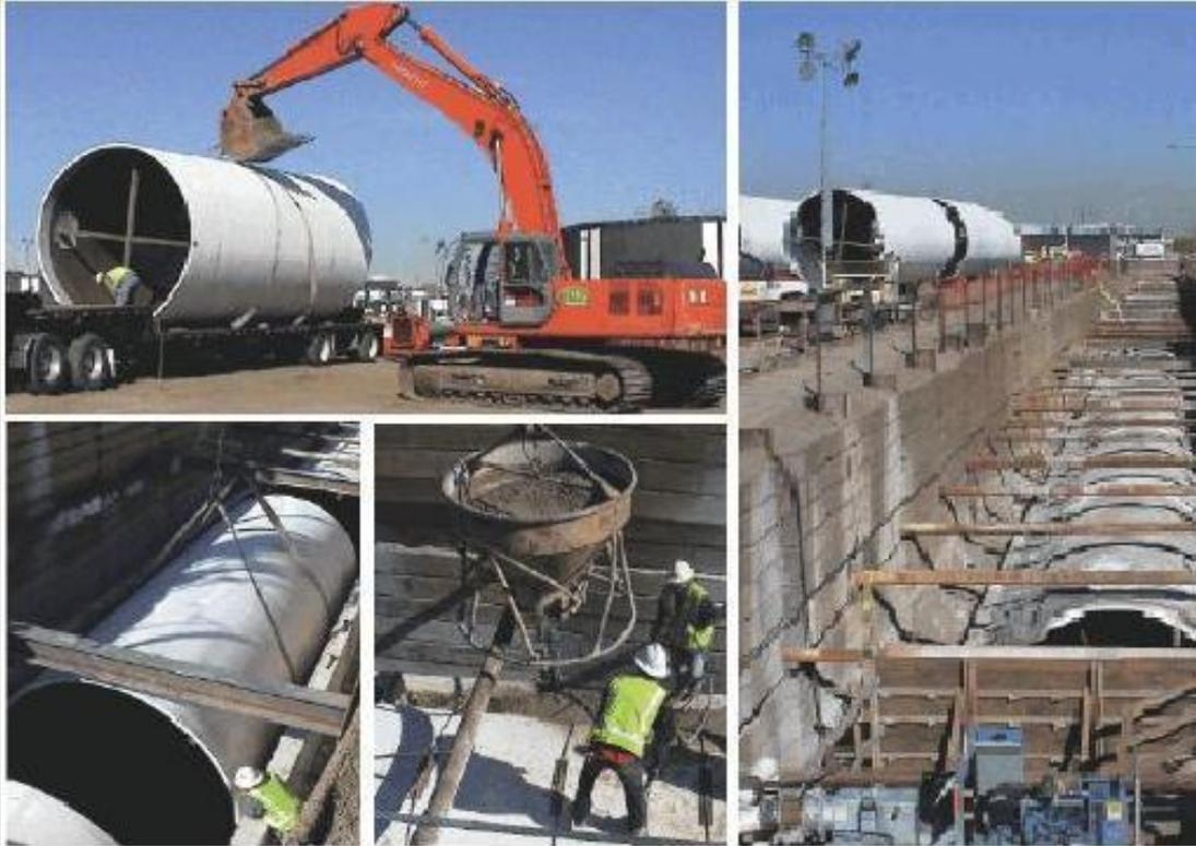
Подземные стеклопластиковые трубопроводы работают совместно с окружающим их грунтом. Грунтовый массив в, котором расположен трубопровод одновременно является нагрузкой на него, основанием, а также средой оказывающей сопротивление перемещению стенок трубопровода. НДС и устойчивость подземных стеклопластиковых трубопроводов диаметрами 1.5 и более метров исследовались в работе [135].
