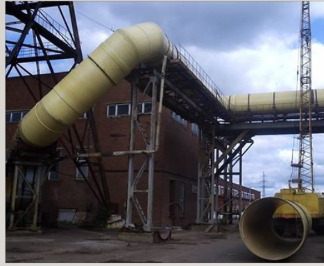
ОАО «ЧМЗ», г. Глазов, Удмуртия. Стеклопластиковые газоходы \varnothing 2.0 м
