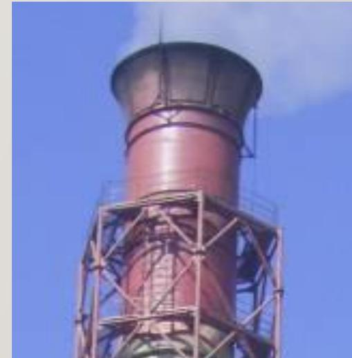
Электростанция STEAG-RWE OHG в Германии. Реконструкция железобетонной трубы с внутренним стеклопластиковым газоотводящим стволом  $\varnothing$  8.0 м и подводящими стеклопластиковыми газоходами
