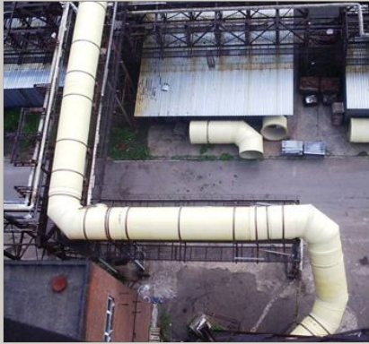
ОАО «ЧМЗ», г. Глазов, Удмуртия. Стеклопластиковые газоходы \varnothing 2.0 м
