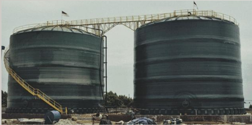
Индонезия. Стеклопластиковые резервуары Ø 20.0 м для хранения фосфорной кислоты
