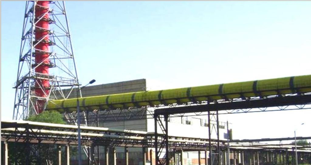
Трехслойный стеклопластиковый газоход диаметром 2.8 м на Чепецком механическом заводе (г. Глазов, Удмуртия)
