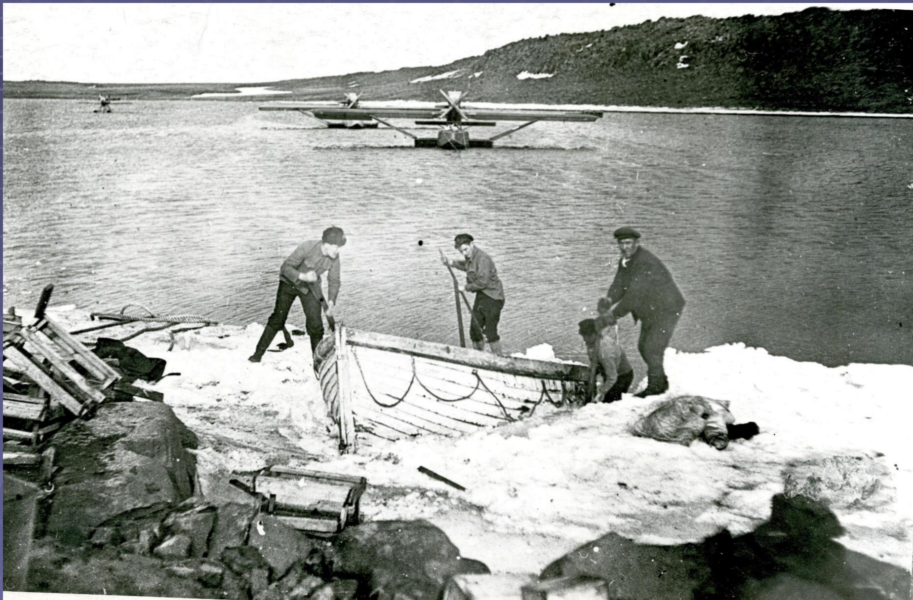
Подготовка причала для швартовки Дорнье Валь, 1931 г.
