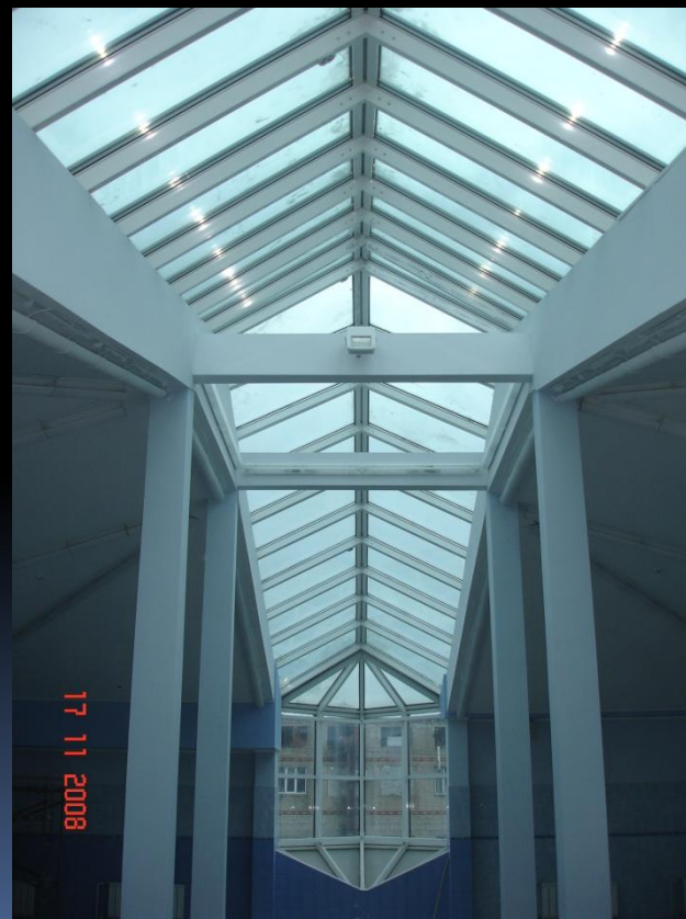
Исполнение на объекте
