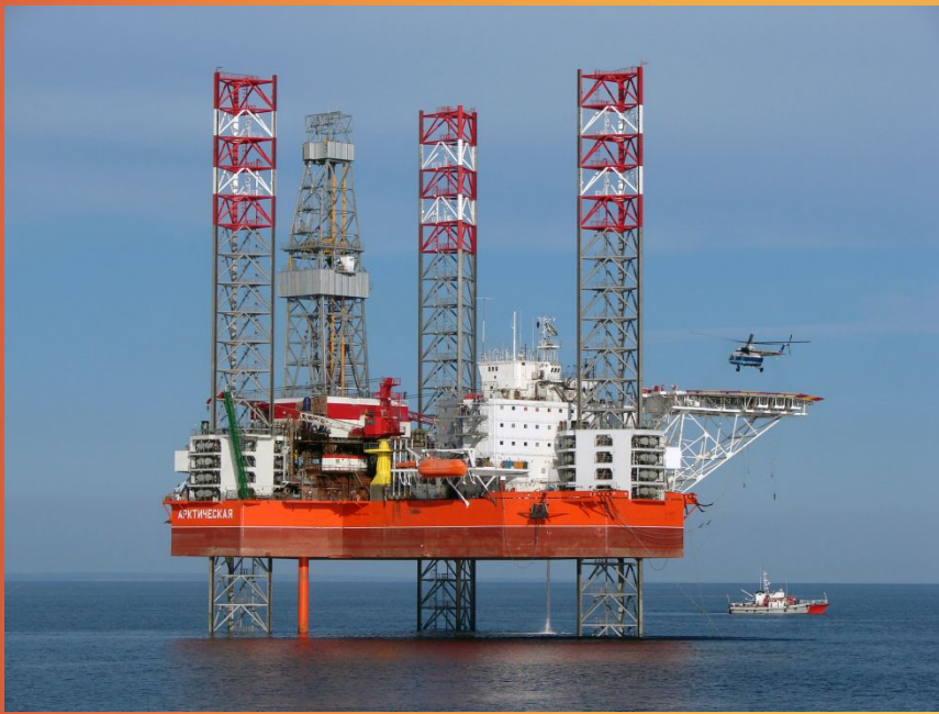
Плавучая бурильная установка на шельфе Охотского моря.
