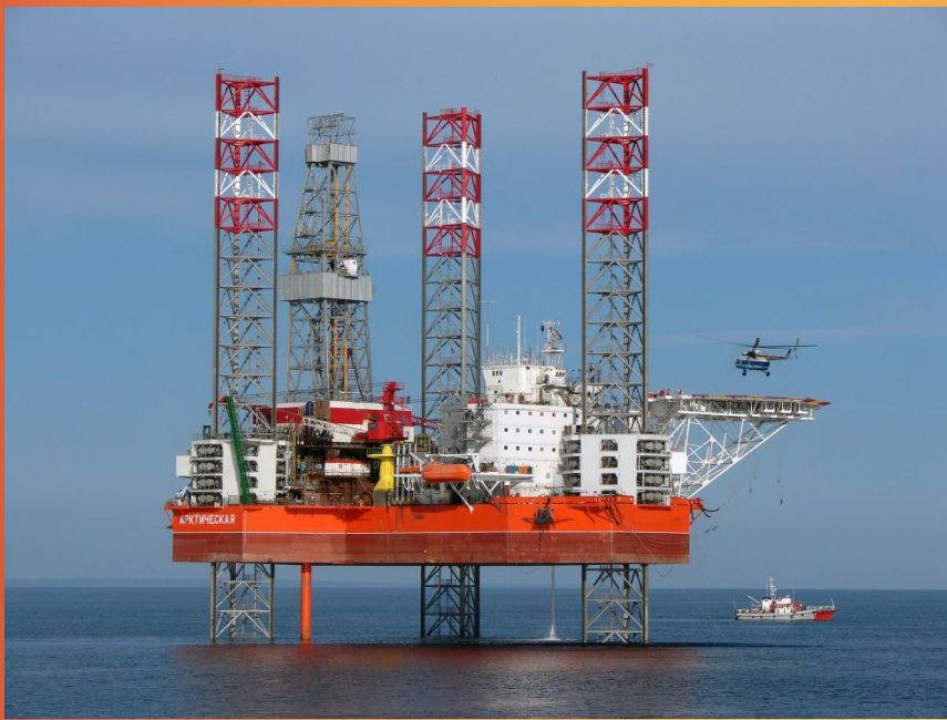
Плавучая бурильная установка на шельфе Охотского моря.
