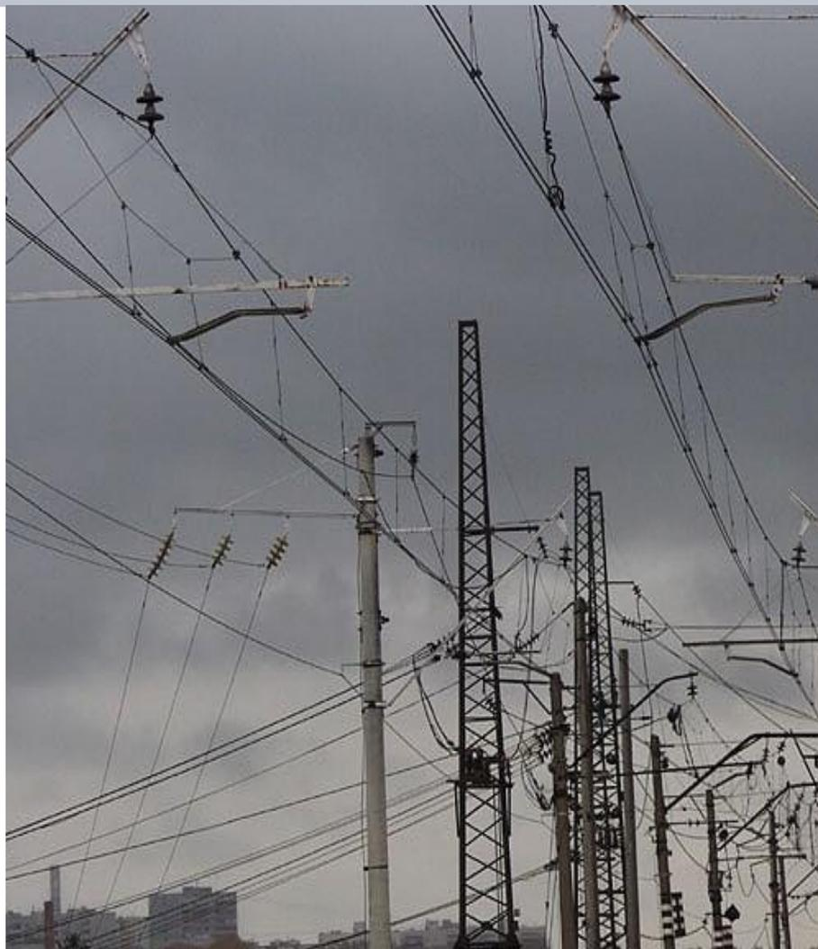
**Несущие тросы** предназначены для передачи электрического тока и подвешивания к нему на струнах контактных проводов.
