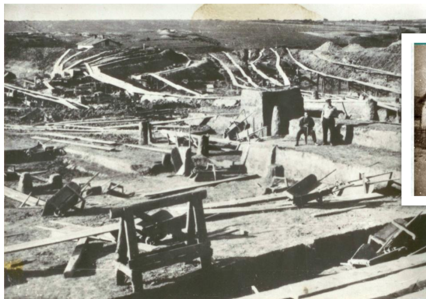
Вид строительной площадки завода. 1932г.
