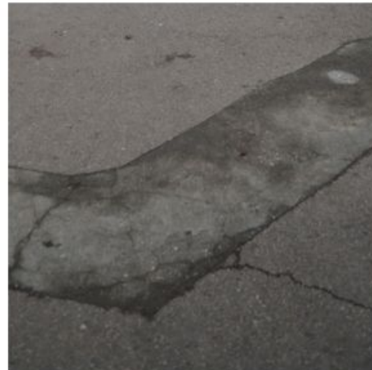
Замена асфальтового покрытия
