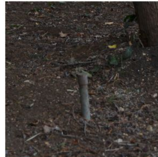
Установка новой оросительной системы
