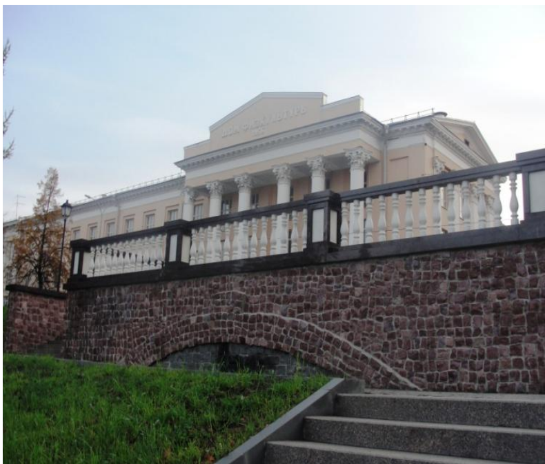
Смотровая площадка лестницы у Дома физкультуры (пересечение улиц Пушкинской и Титова, г. Петрозаводск.
