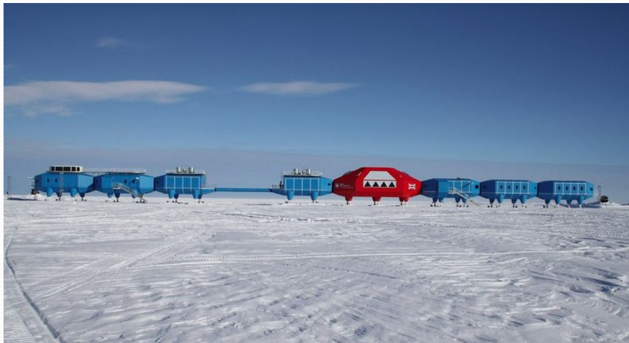
Модульная британская станция Halley VI
