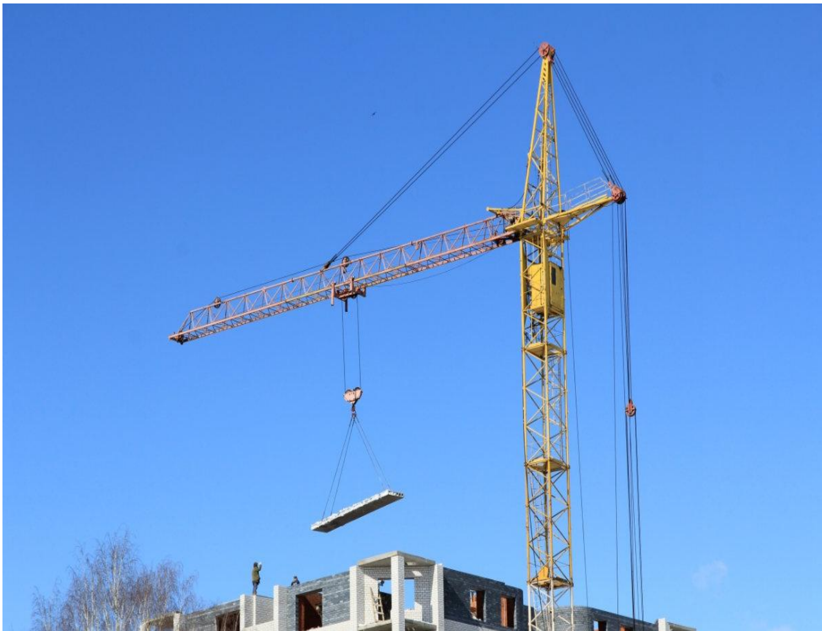
⦿ Кран со стрелой балочного типа.
