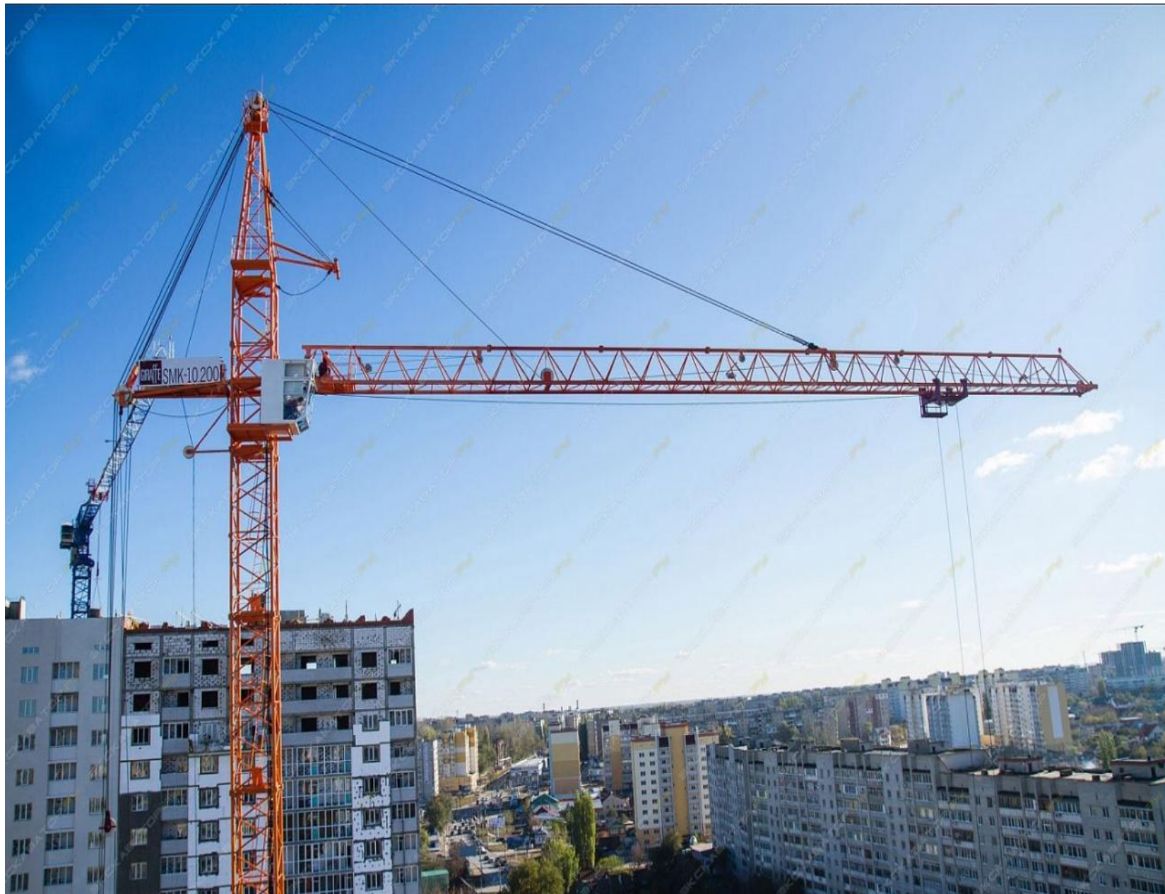
⦿ Подъёмный кран с оголовком.
