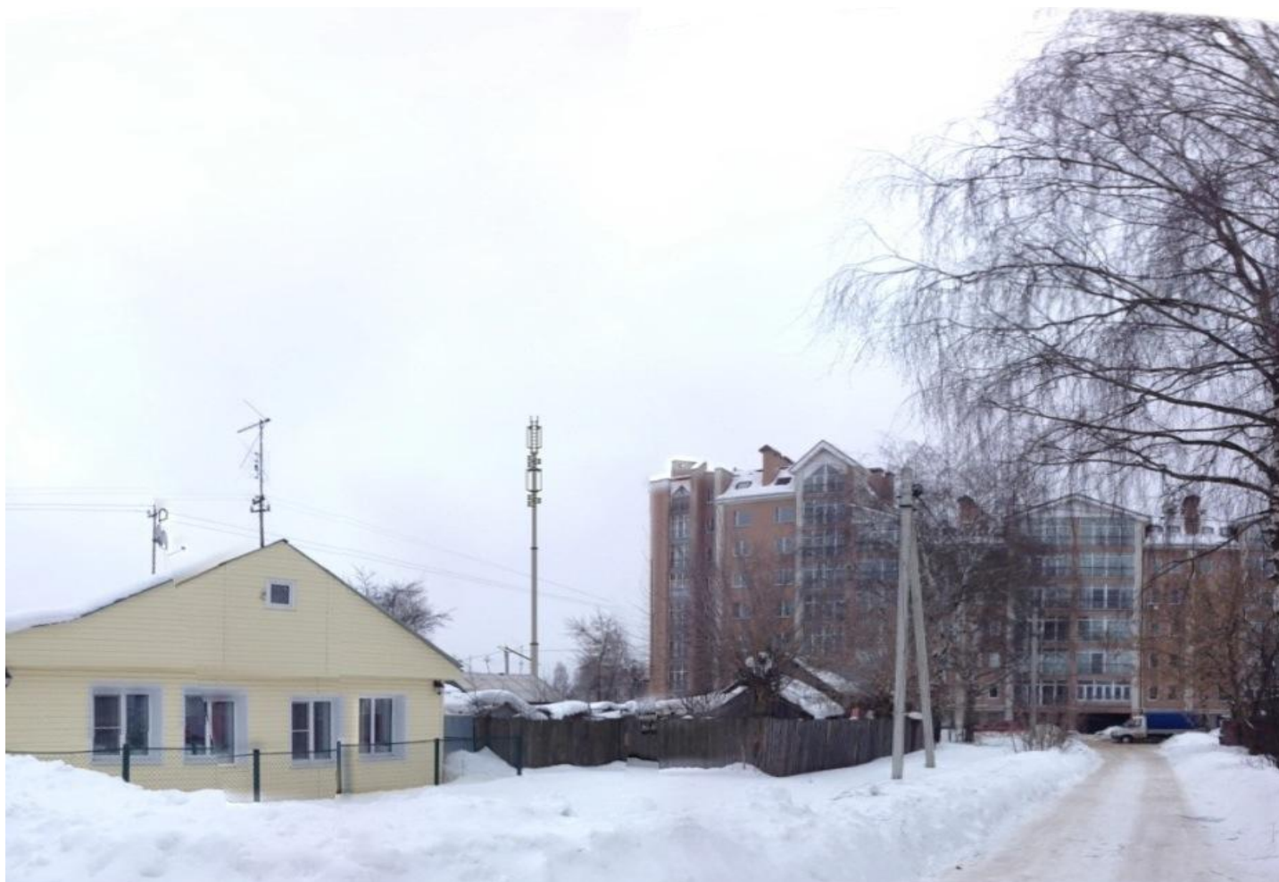
Металлическая многофункциональная опора Н=21-30 м
