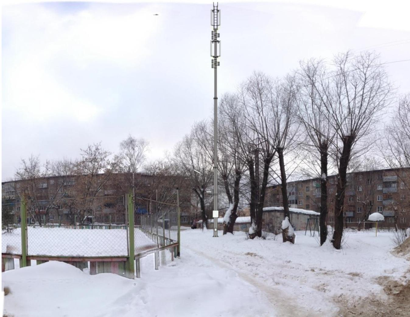
Металлическая многофункциональная опора Н=21-30 м
