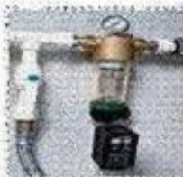
Фильтры для удаления механических примесей используются для осветления воды, улавливают крупные частицы, бывают фильтры грубой и тонкой очистки, работают благодаря материалу на основе алюмосиликатов. Недостаток этих фильтров: осуществляют только предварительную водоподготовку;
