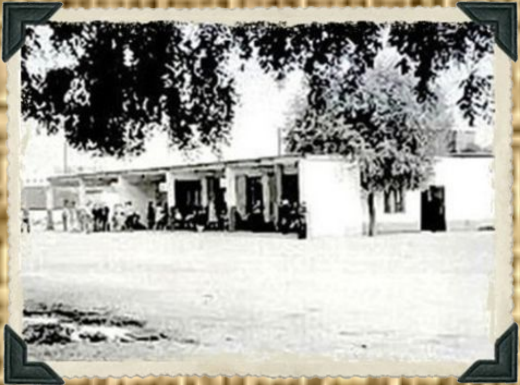
Автостанция. Улица Скорохода
