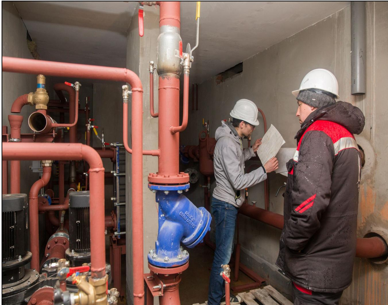
Тепловые испытания, проводились с целью наладки и выявления дефектов в работе котельной установки, являются отправным моментом для решения вопроса о мероприятиях, направленных на повышение надёжности и улучшение эксплуатационных характеристик агрегатов.
