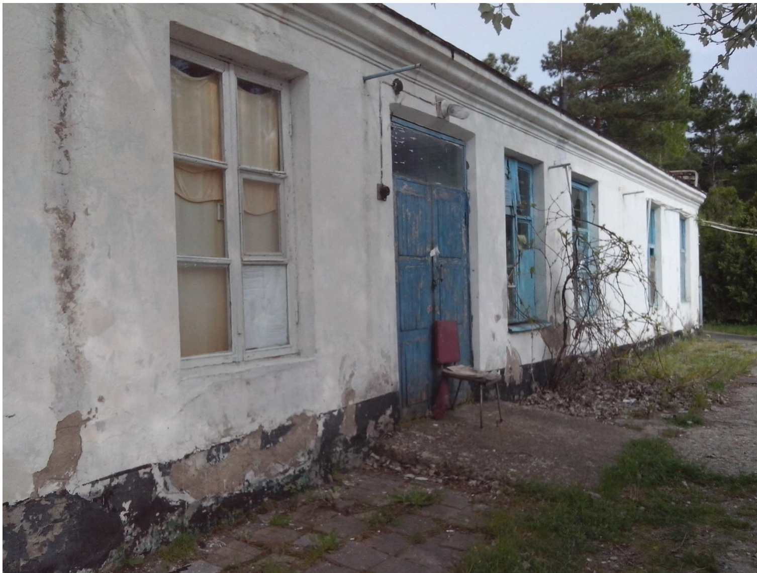
Здание изолятора, литер С
