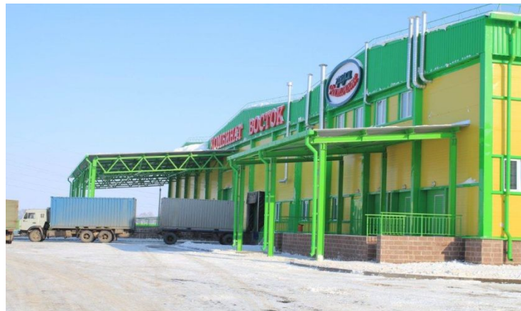
Картофелеплодоовощехранилище на 22,5 тыс. тонн
