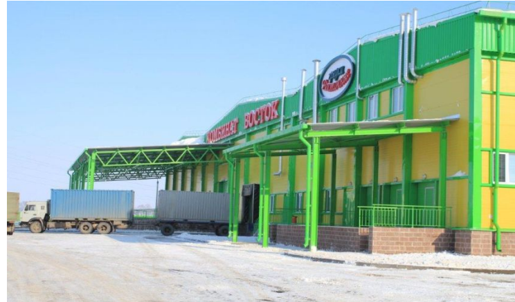
Картофелеплодоовощехранилище на 22,5 тыс. тонн
