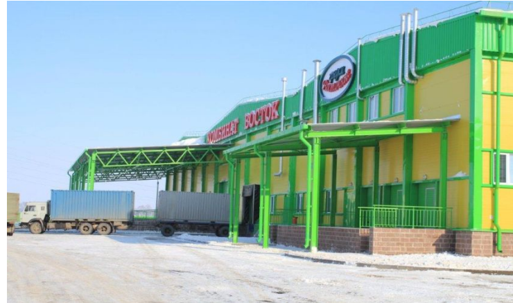
Картофелеплодоовощехранилище на 22,5 тыс. тонн
