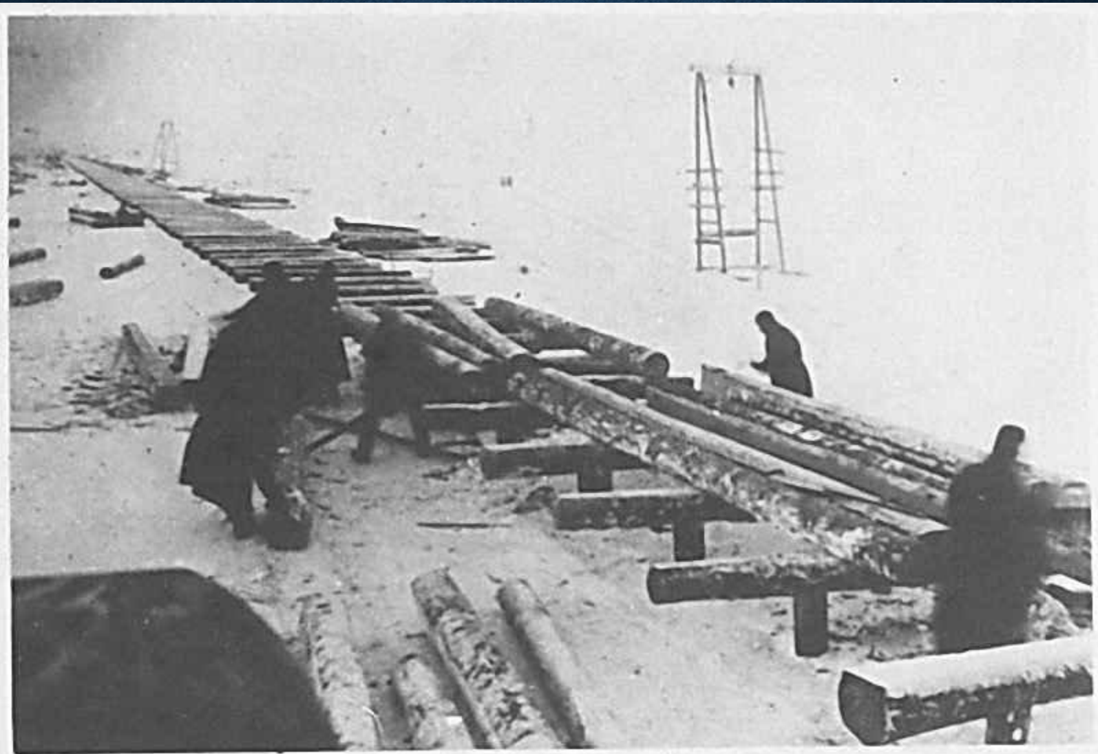
УКЛАДКА ПРОГОНОВ НА УЧАСТКЕ 40-го Ж. Д. БАТАЛЬОНА.
