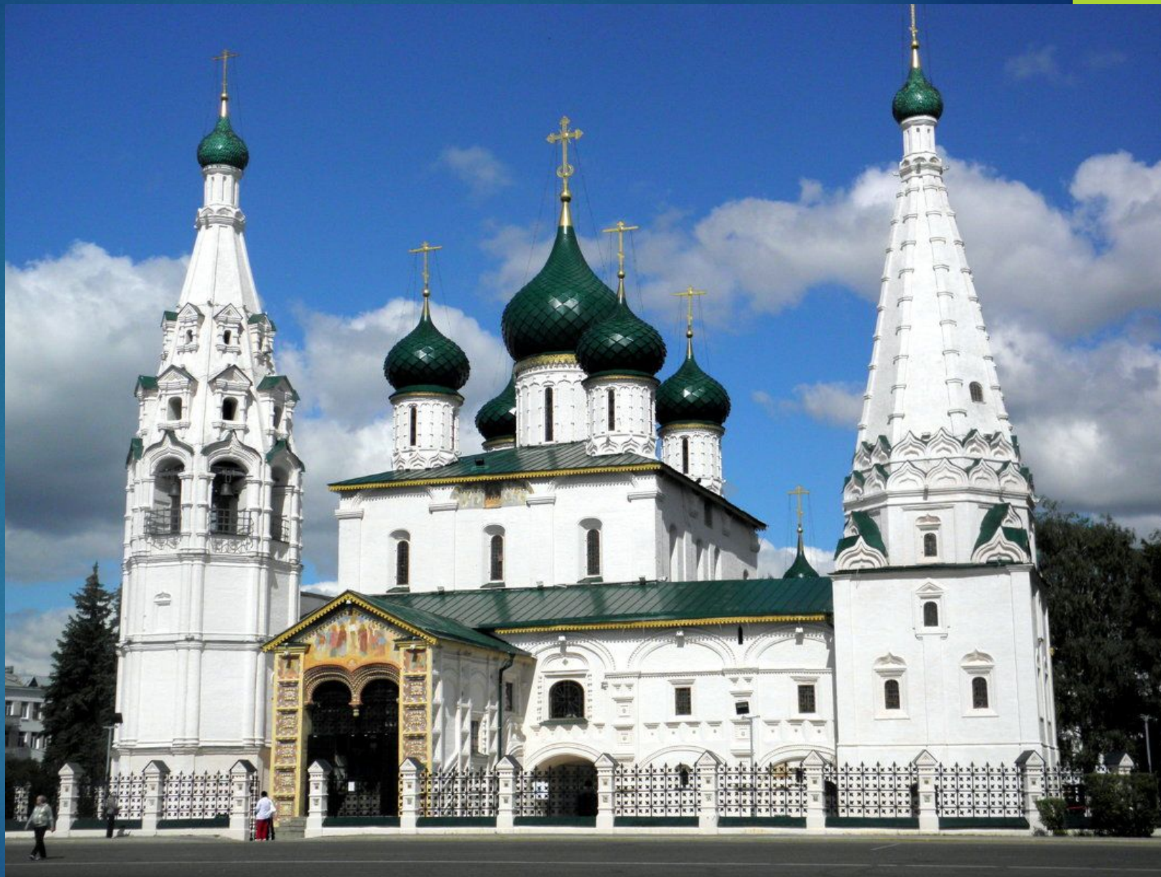
Церковь Ильи Пророка в Ярославле.
