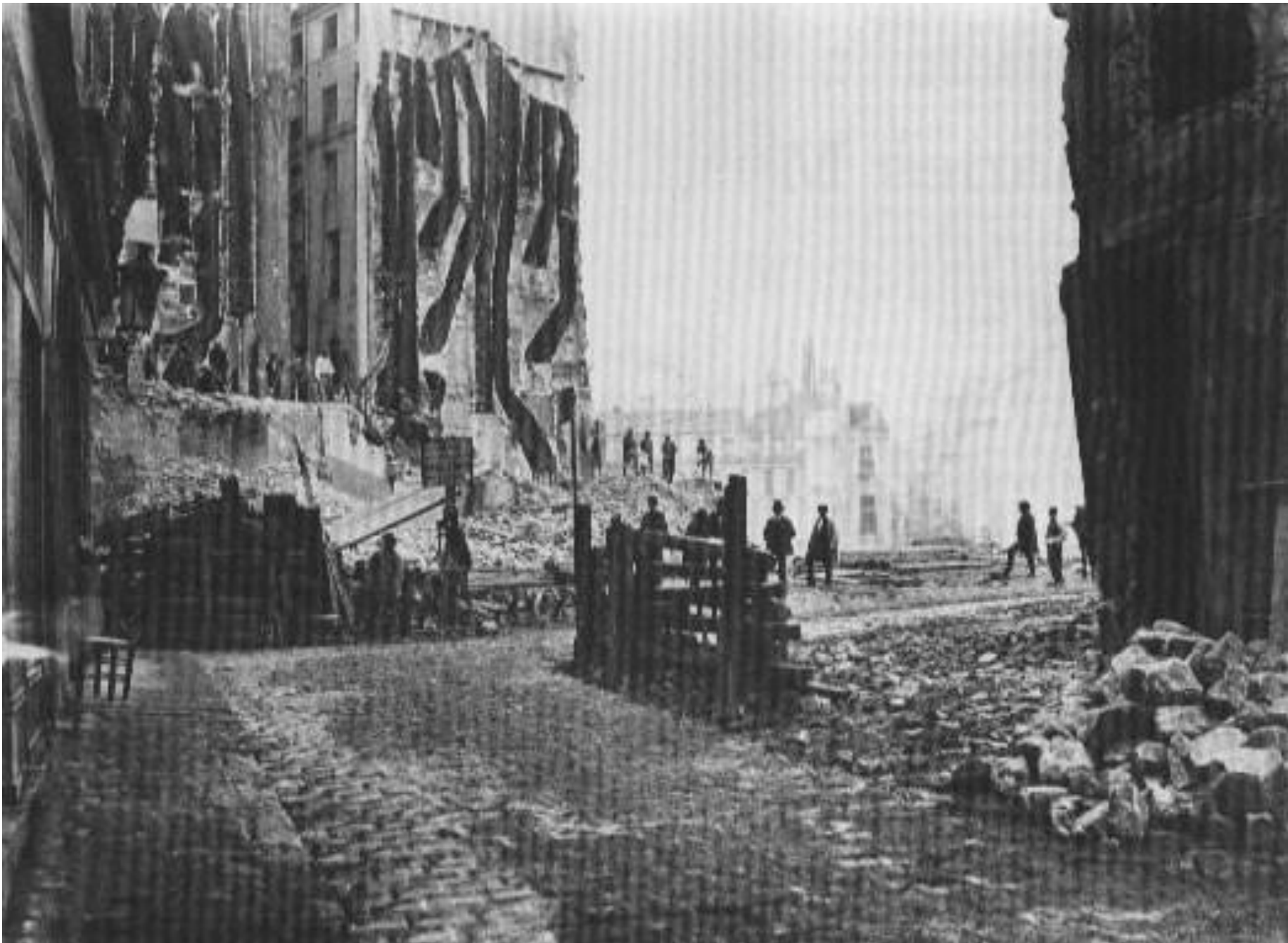
Прокладывание проспекта Опера
