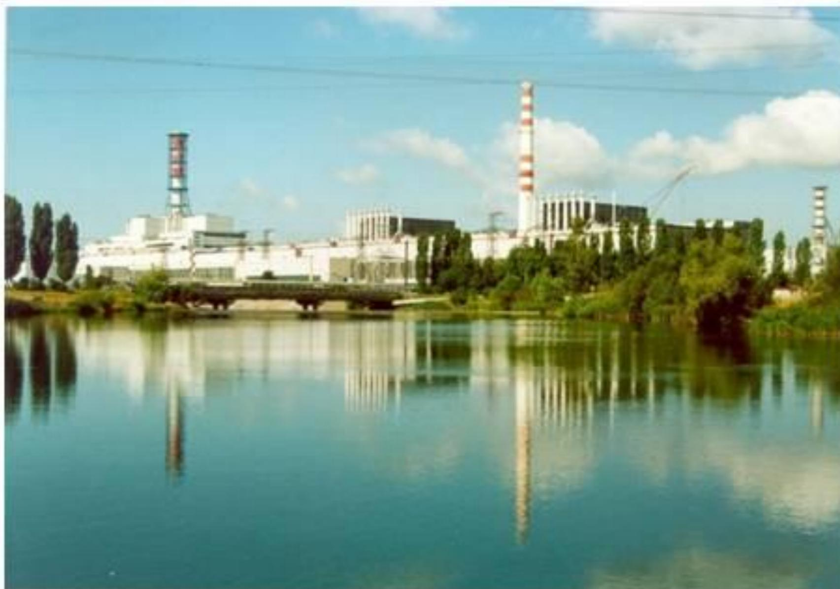
**Чтобы не произошло загрязнение окружающей среды, вода всех технологических контуров АЭС включается в систему оборотного водоснабжения. Тем не менее, часть жидких стоков сбрасывают в водоем-охладитель, имеющийся при каждой АЭС. Этот водоем является слабопроточным бассейном (чаще всего это искусственное водохранилище), поэтому сброс в него жидкостей, содержащих даже малое количество радионуклидов, может привести к опасной их концентрации.**
