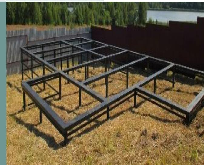
**Поверхностный фундамент.** Он применяется при строительстве легких строений (летний домик, беседка, туалет). Поверхностный фундамент выполняется непременно на сухом и плотном грунте. Основой поверхностного фундамента являются опорные плиты.
