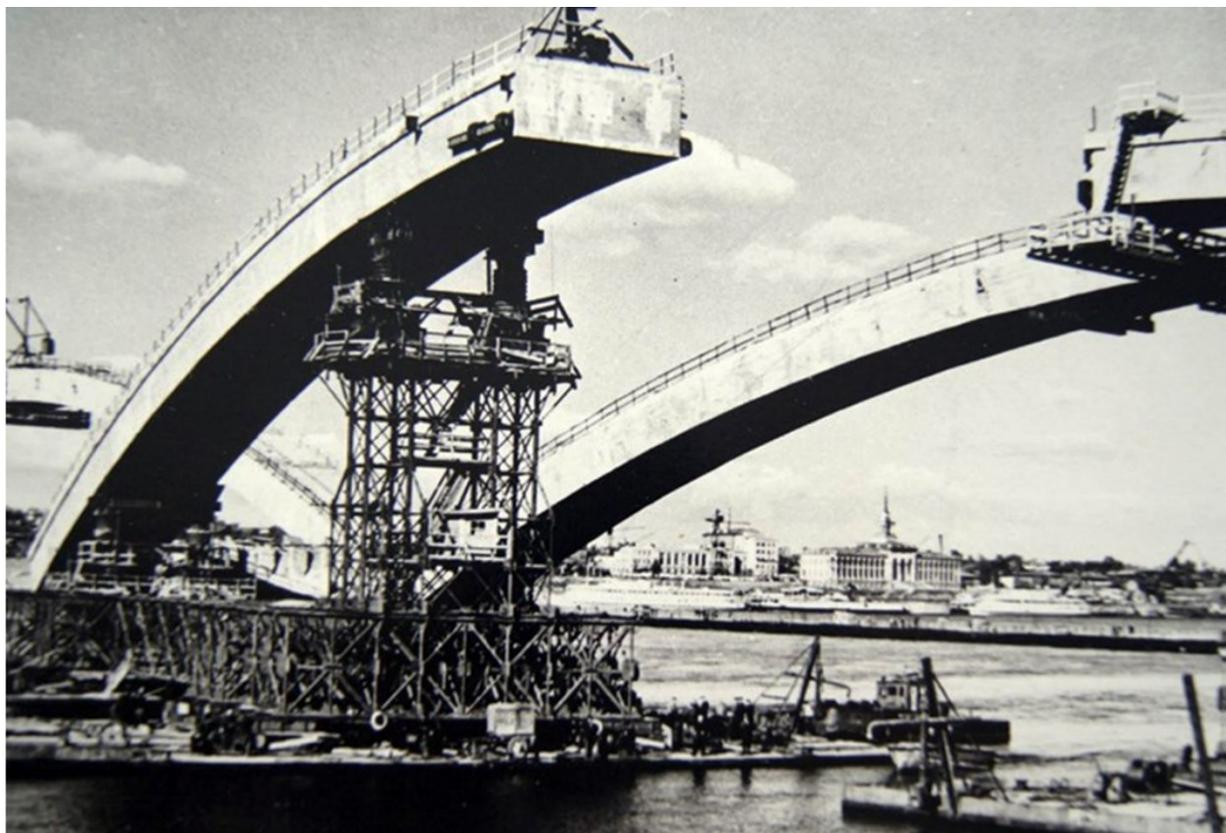
Главной особенностью строительства Коммунального моста стала установка полуарок (в количестве двадцати штук весом 1560 тонн) с помощью плавсистем — плавучих опор и их буксировки с помощью теплоходов к месту монтажа. 17 октября 1961 года после испытания на прочность мост был принят в эксплуатацию с оценкой «отлично». Акт о приёмке в эксплуатацию был подписан 15 ноября 1961 год, хотя движение на мосту было открыто 17 октября 1961 года
