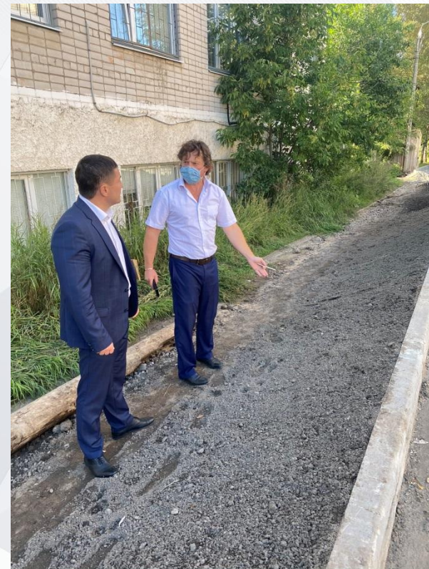
Ремонт дворов ул. Некрасова дд. 70б, 72 (фото процесса)
