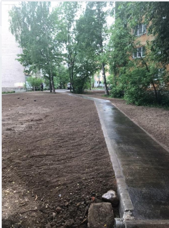
Ремонт дворов ул. Горького д. 116, д. 118, 120а (фото процесса)
