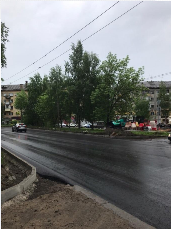
Ремонт улицы Горького (фото процесса)
