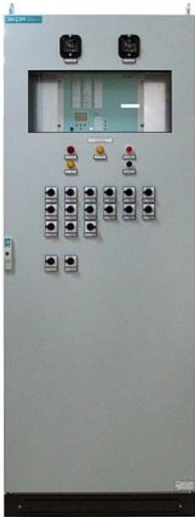
Микропроцессорное устройство защиты линии типа ШЭ 2607 041
