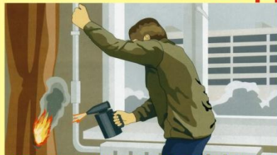
Отогревание замерзших труб паяльными лампами и факелами и другие работы открытым огнем.
