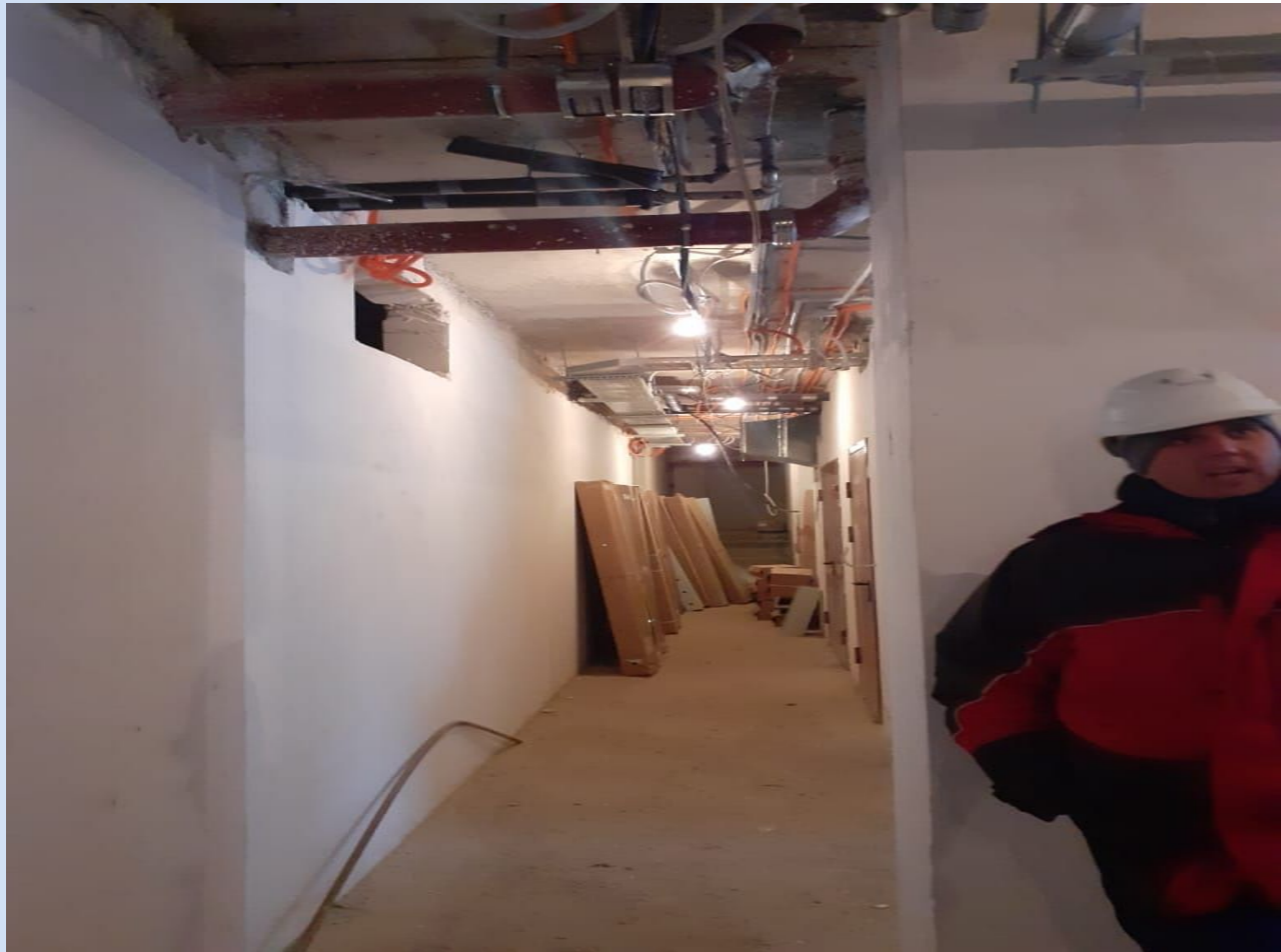
Корпус №6. Не завершены монтажные работы сантехнического и вентиляционного оборудования, слаботочных систем, систем электроснабжения, противопожарных систем.
