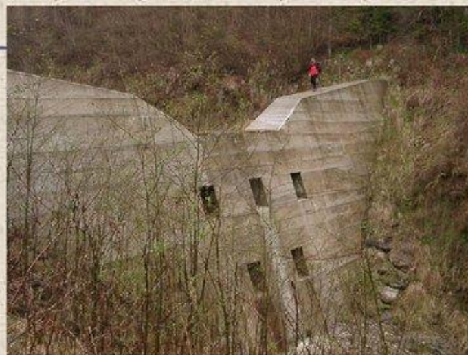
Селезадерживающая плотина с пятью пропускными отверстиями.
