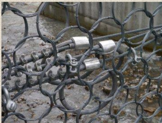
Сетка из колец ROCCO® и кольца амортизаторы.
