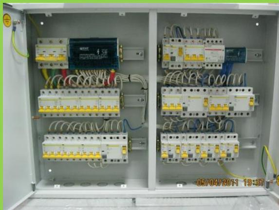
**Щиток электрический учетно-групповой** - устройство для учета и распределения электрической энергии внутри квартир, жилых, общественных и производственных зданий, а также защиты распределительных цепей при перегрузках, коротких замыканиях и недопустимых токах утечки на землю в сетях с глухозаземленной нейтралью.
