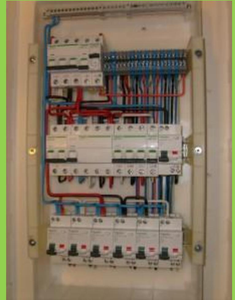
**Групповой щиток** - устройство, в котором установлены аппараты защиты и коммутационные аппараты (или только аппараты защиты) для отдельных групп светильников, штепсельных розеток и стационарных электроприемников.
