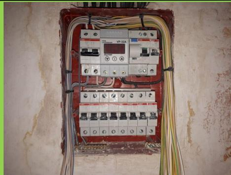
Вначале следует собрать щит без коммутации, отмечая места установки приборов. При этом следует предусмотреть возможность быстрого отключения питания изнутри и снаружи. Когда щиток закрыт, должна быть обеспечена возможность быстрой проверки наличия напряжения с помощью индикаторной отвертки или лампочки.
