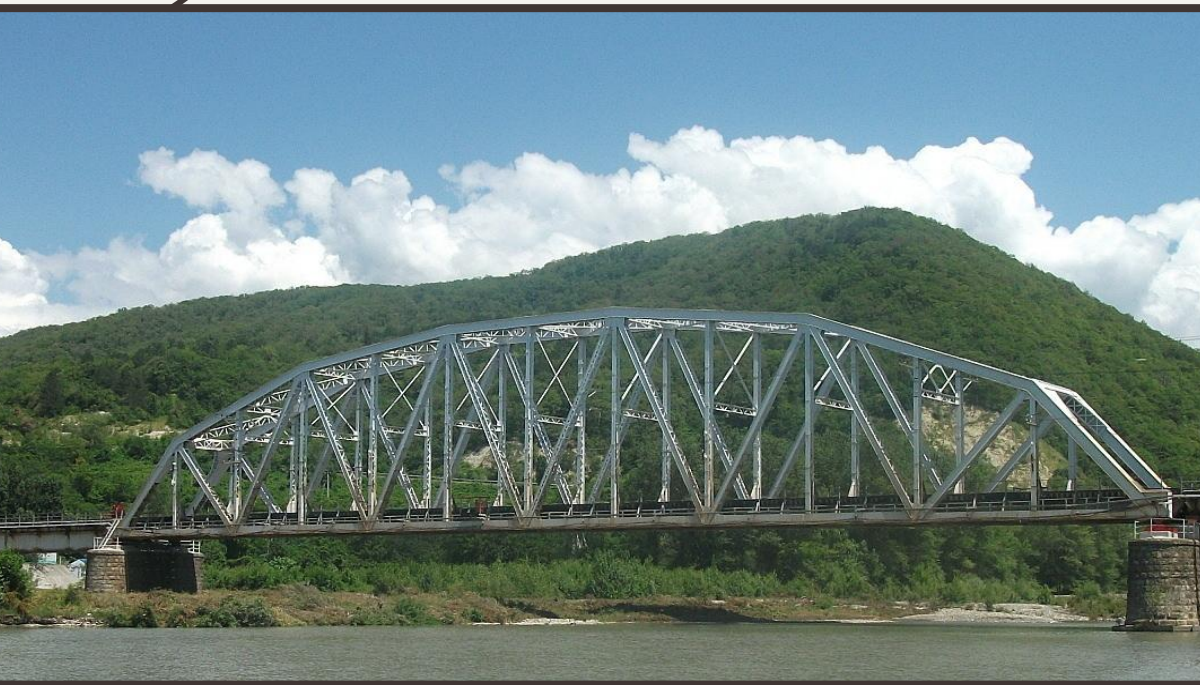
Железнодорожный мост над рекой Аше в Сочи.
