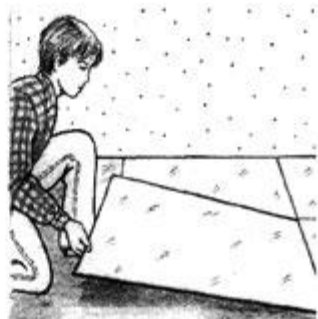
15 Дополнительный слой плит
