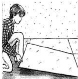
15 Дополнительный слой плит
