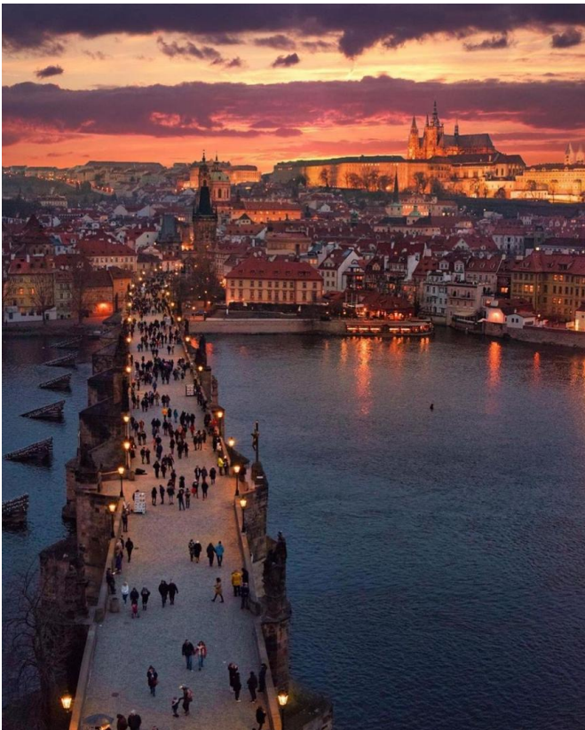
Карлов мост через р. Влтаву (1357 – 1402)
