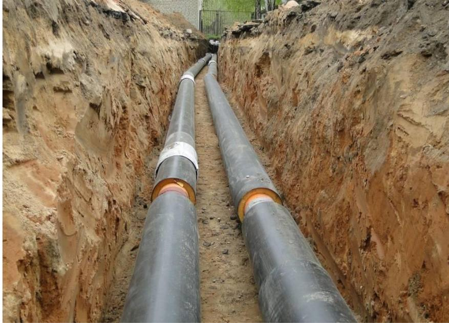
При бесканальной прокладке потери теплоты осуществляются за счет теплопроводности через стенку трубы, слой изоляции и грунта. Величина потерь теплоты зависит от глубины залегания трубопровода, теплопроводности грунта и его температуры.
