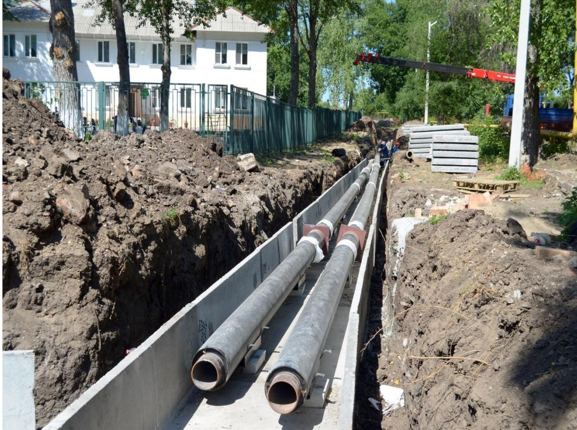
В случае канальной прокладки потери теплоты обусловлены конвекцией и излучением от поверхности изоляции трубопровода к внутренней поверхности канала, а далее теплопроводностью теплота передается слою грунта.
