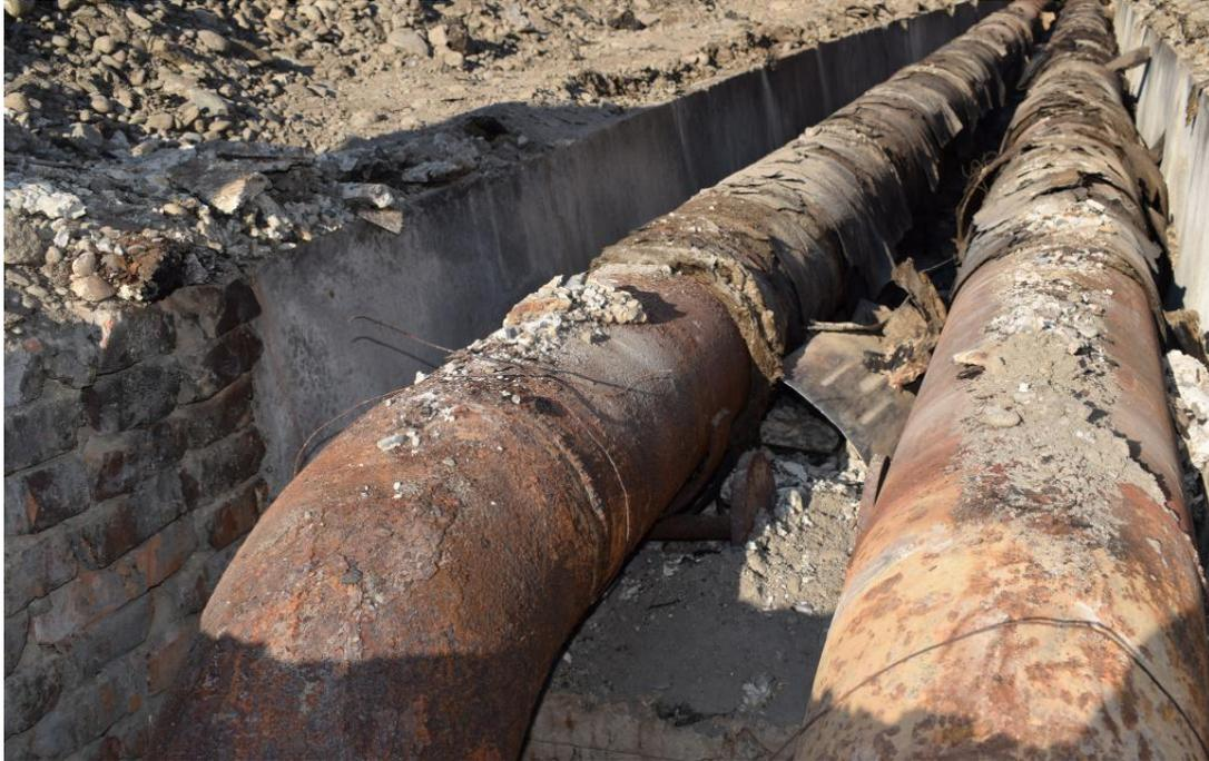
Интенсивность поражения объектов тепловых сетей наружной коррозией превышает соответствующую интенсивность внутренней коррозии в 4,7 раза.
