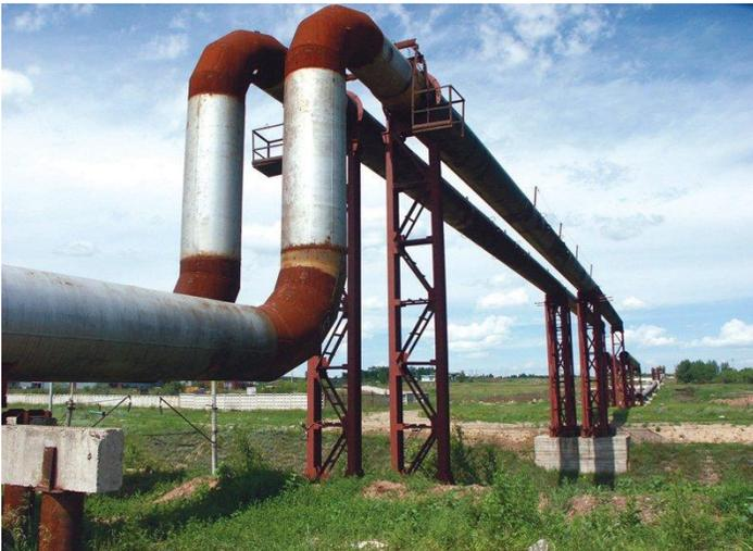
При надземной прокладке потери теплоты с поверхности изолированного трубопровода происходят за счет конвекции с учетом воздействия ветра.
