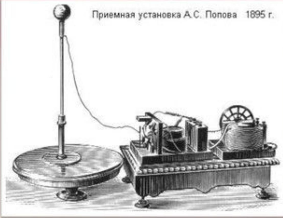
Апаратура О. Попова стала використовуватися 1897 р. на Балтійському флоті, для чого О. Попов виготовив 15 радіостанцій,
