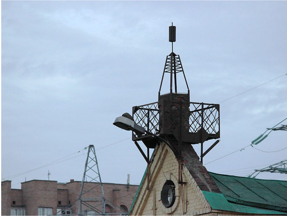
Полигонометрический знак 2 класса на крыше здания
