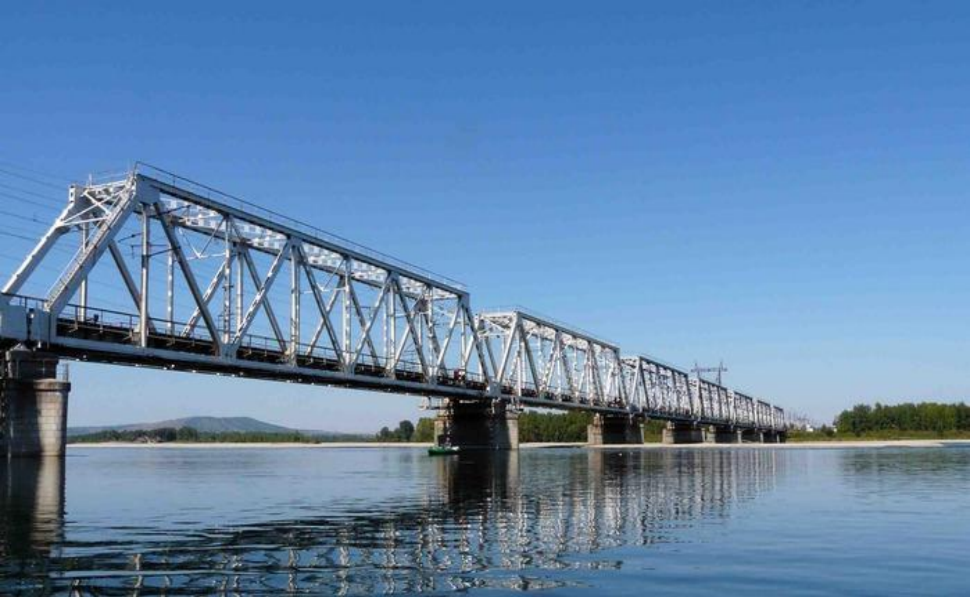
Мост через р.Туба
