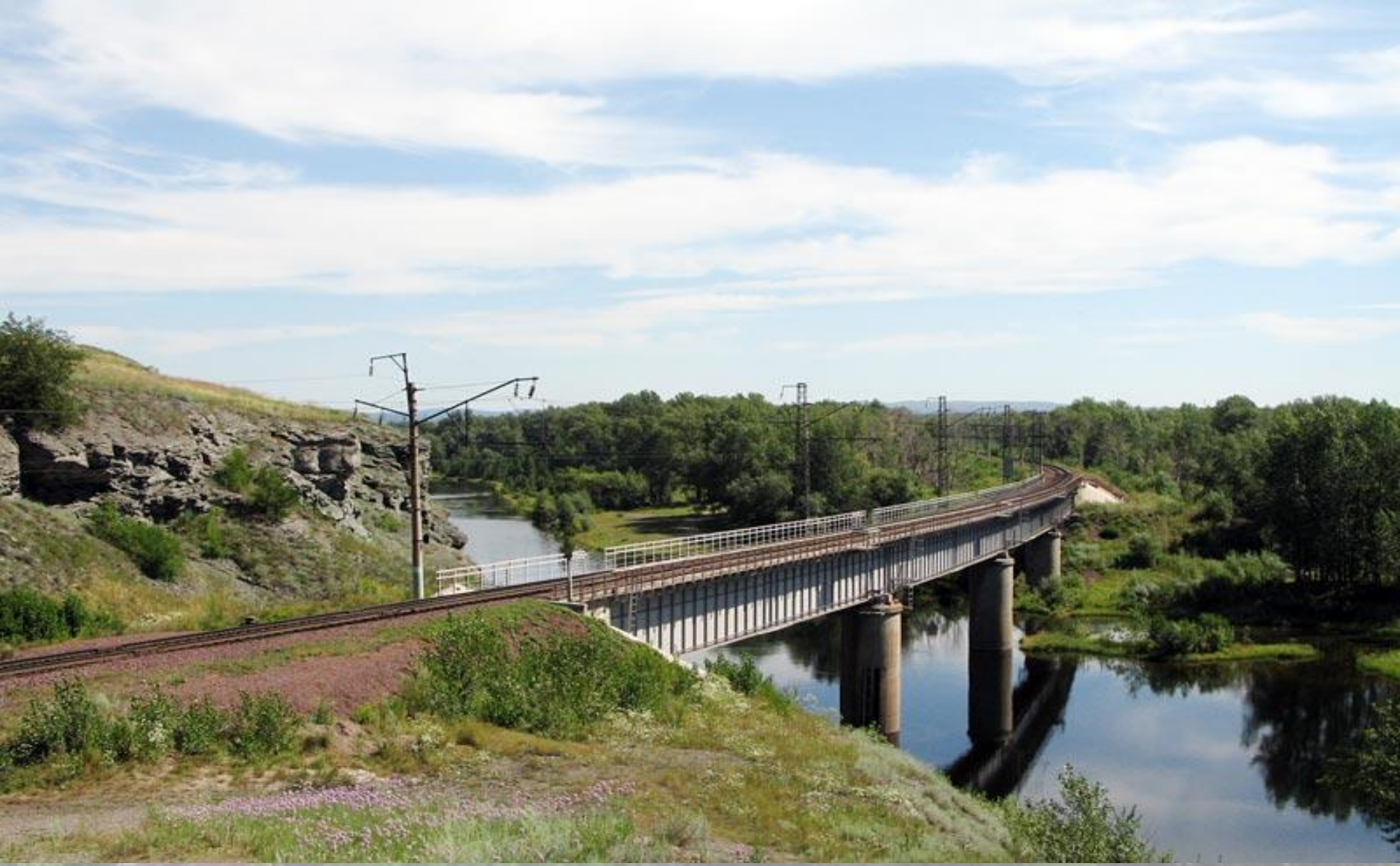
Мост через Минусинскую протоку
