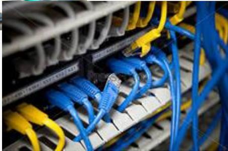
По этой причине, сетевые сегменты, основанные на витой паре гораздо стабильнее в работе сегментов на коаксиальном кабеле, поскольку в первом случае каждое устройство может быть изолировано концентратором от общей среды, а во втором случае несколько устройств подключаются при помощи одного сегмента кабеля, и, в случае большого количества коллизий, концентратор может изолировать лишь весь сегмент.
