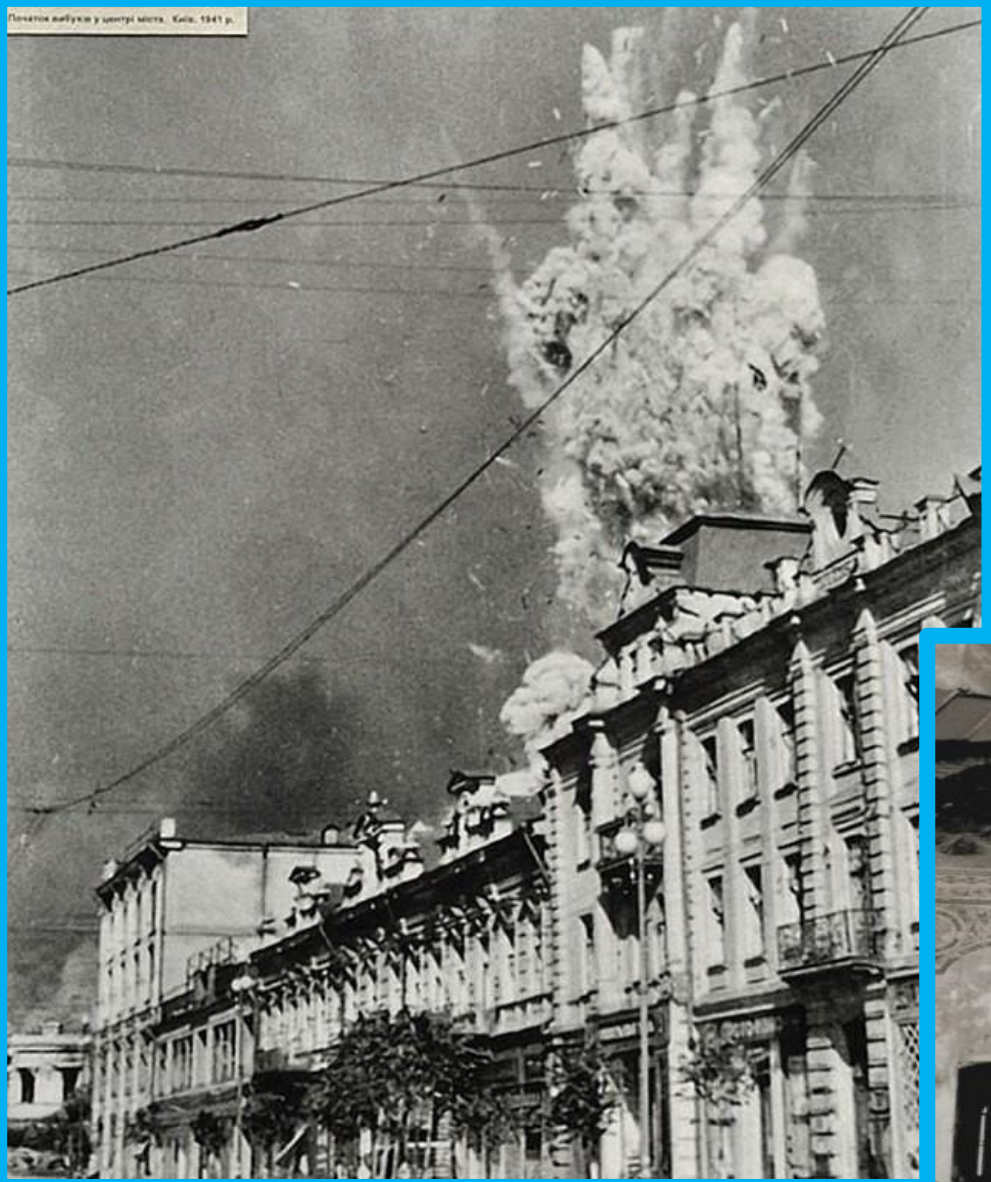
Момент попадания мины в здание, 1941 г., Киев
