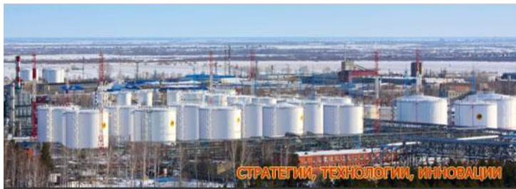
Антипинский нефтеперерабатывающий завод
