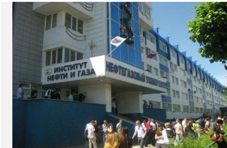
Институт нефти и газа ТюмГНГУ, г. Тюмень
