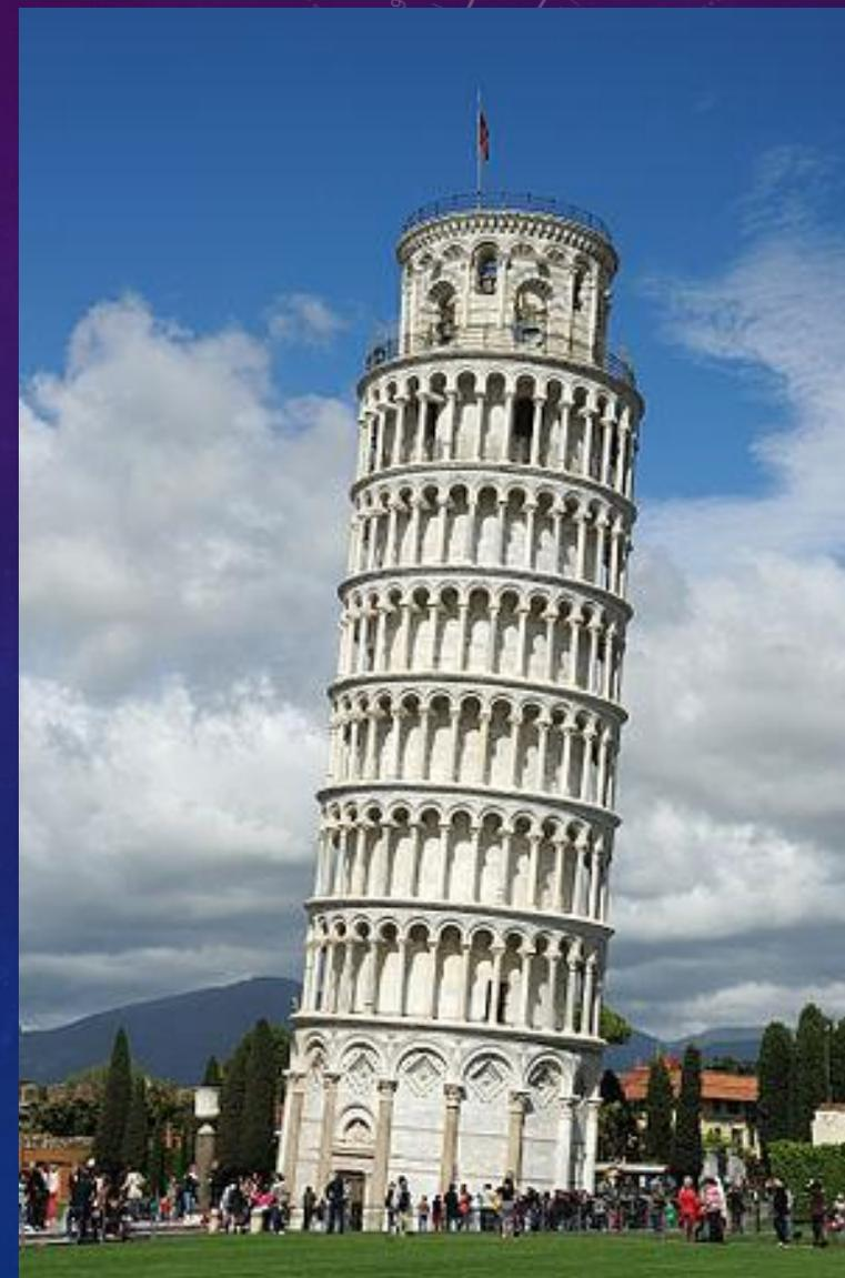
Диаметр основания колокольни, имеющей цилиндрическую форму, составляет 15 метров 54 сантиметра. Толщина внешних стен у основания составляет 4 метра 90 сантиметров, а у вершины – 2 метра 48 сантиметров. Ее отклонение от вертикальной оси на уровне основания составляет 4 метра, а на уровне вершины – 5 метров 30 сантиметров. На верхний уровень кампанеллы возносятся 294 ступени. А уж оттуда туристам, одолевшим восхождение, открывается красивый вид на Поле Чудес и ближайшие окрестности.
