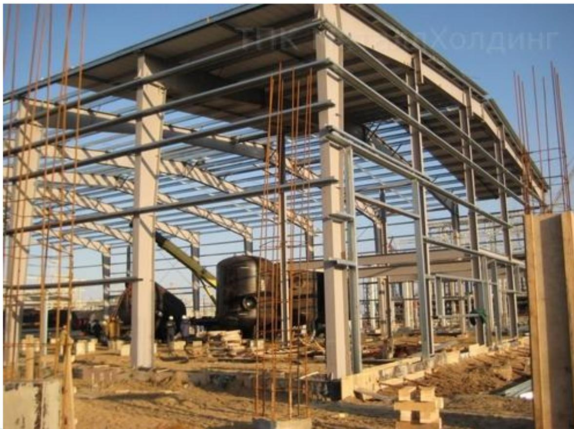
**Одноэтажные промышленные здания применяют тогда, когда технологический процесс производства промышленной продукции осуществляется в горизонтальной плоскости**
