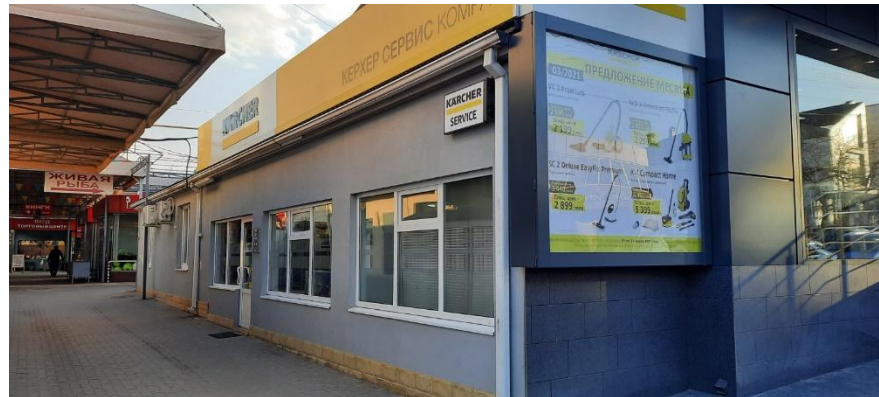
Сервисный Центр фил. г. Комрат / Реконструкция
