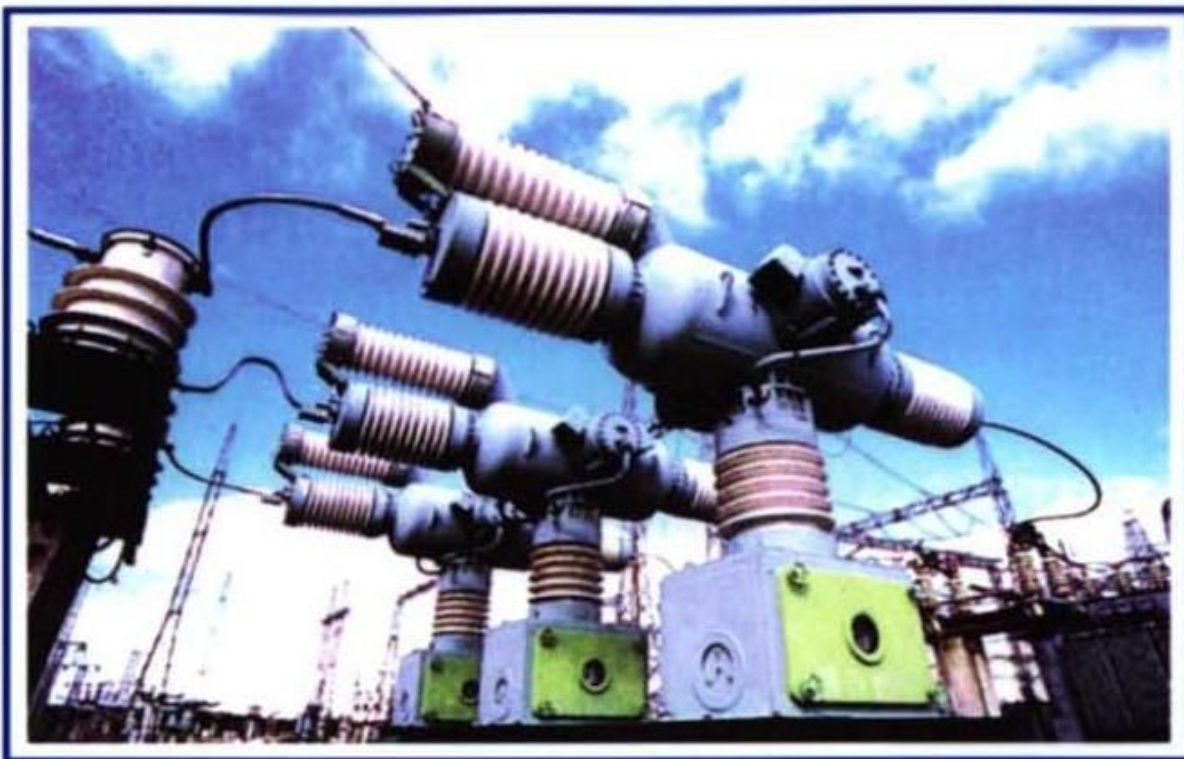
Воздушный выключатель
